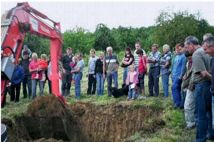
Suche nach der vergrabenen Kanone 2008
