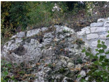
Abb. 3: Ein kurzes Teilstück der Ringmauer (links) ist unrestauriert erhalten
