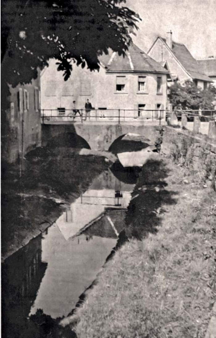
Abb. 2: Vor dem Abbruch der alten Brücke im Jahr 1957
