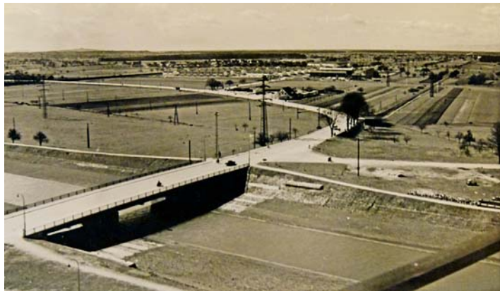
Abb. 6: Foto der Kinzig-Straßenbrücke von 1950 mit Schmalspurbahn, 1955_ StA-OG_04.032-37
