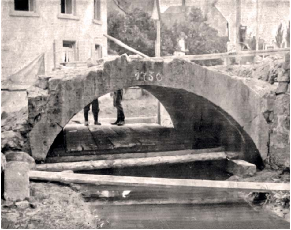
Abb. 1: Abbruch der alten Brücke (Jahreszahl 1756 noch zu erkennen)
