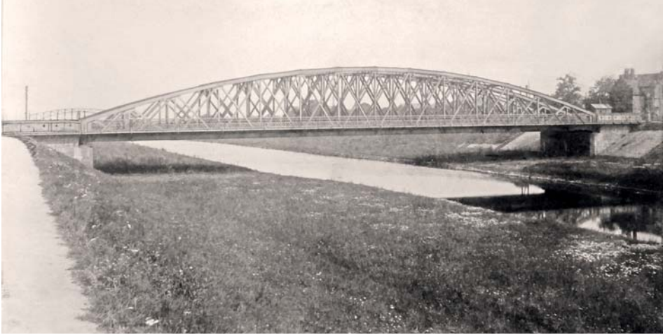
Abb. 13: Historisches Foto der dritten Kinzigbrücke, nach 1900_ StA-OG_04.027-20
