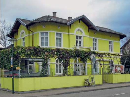
Abb. 28: Ehemaliges Bahnhofshotel Wenk (heute Alte Post/ Eisenbahnstraße 34). Foto: Coenen
