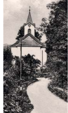
Abb. 9: Die Bohlsbacher Straße beim Ortseingang Ebersweier (zwischen 1920 und 1964, Aufnahme vor 1964)
