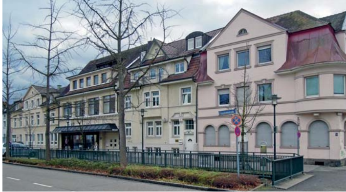
Abb. 31: Die Reihenbebauung Eisenbahnstraße 31, 33, 35 und 37 entstand im späten 19. und frühen 20. Jahrhundert. Foto: Coenen
