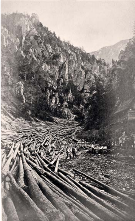
Abb. 8: Auslauf einer Stammholzriese (Ybbstal). – Foto: Helm (um 1872), in: Ausstellung (wie Anm. 30).
