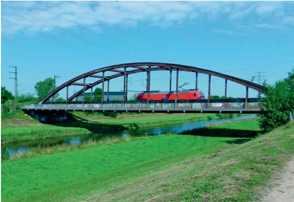
Abb. 16: Foto vom aktuellen Zustand der Eisenbahnbrücke, 2014_Boeyng
