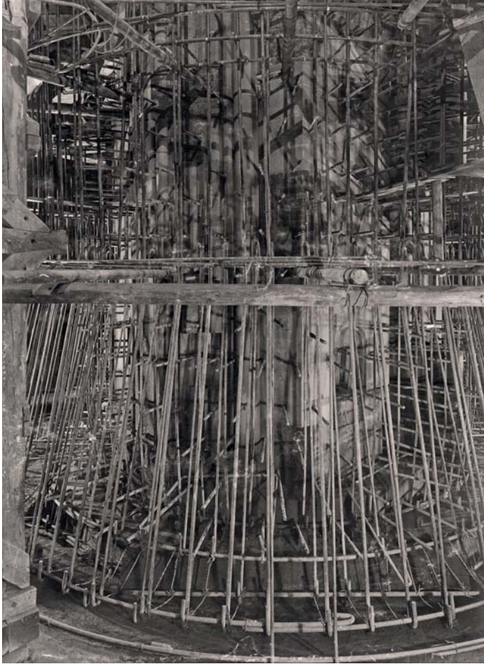
Abb. 10a: Vorbereitung des Stahlbetonkorsetts um den Turmpfeiler
