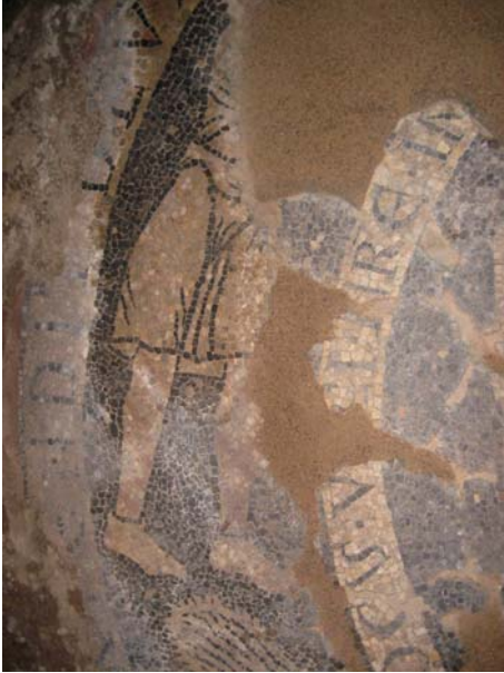
Abb. 9: „Feuchte“ Flecken mit weißen Auflagerungen, die sie umgeben, vor der Reinigung.
