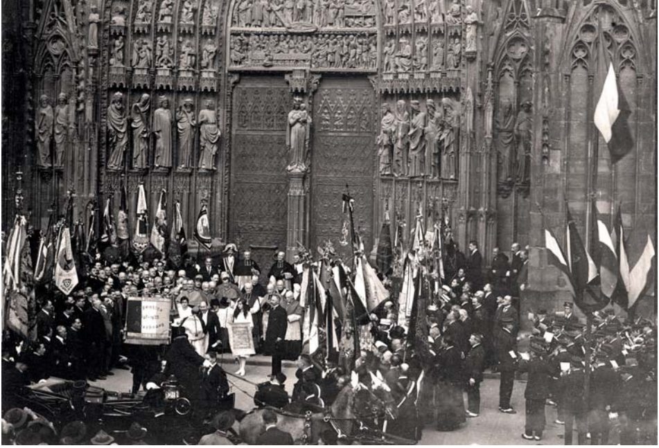
Abb. 15: Feier zum Abschluss der Turmpfeilerarbeiten, 9/10. Oktober 1926
