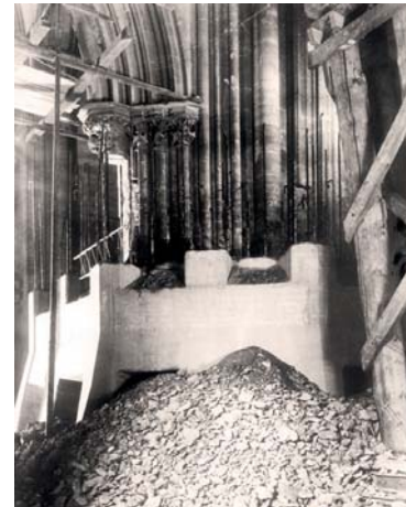
Abb. 14 (unten): Stahlbetonkorsett und Schutthalde
