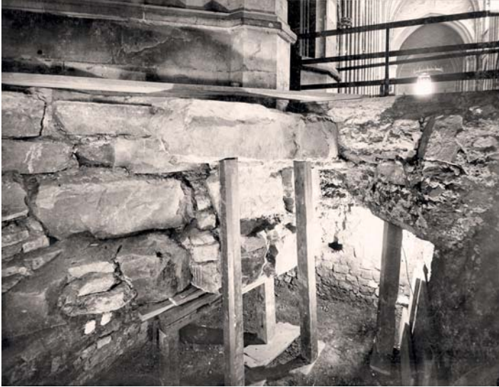
Abb. 8: Grabungsbereich unter dem Turmpfeiler (links: gotische Fundamente, rechts: romanische Fundamente)
