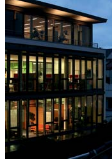
Der Erweiterungsbau in der Ratskellerstraße nach Fertigstellung im Jahr 2006
