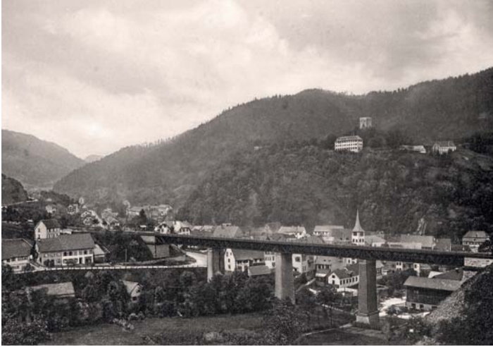
Abb. 12: Bahnviadukt in Hornberg (150 m lang, 24 m hoch), erbaut 1871. – Foto Felix Luib, 1896. – H. Harter
