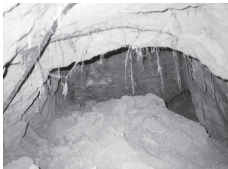
Abb. 4: Das Ende des Fluchtstollens vor der Stadtmauer
