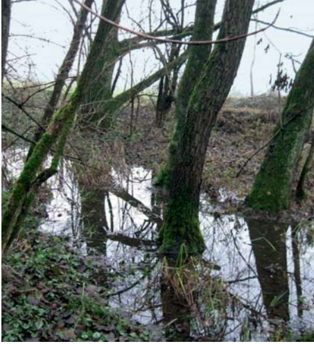
Abb. 2: Im südlichen Randbereich der Burg steht zeitweise Wasser im Graben
