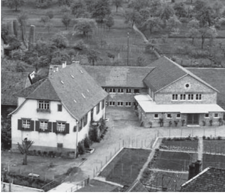
Abb. 5: (links) Das Schwesternhaus mit dem Erweiterungsbau des Kindergartens und Neubau der Turnhalle im Jahr 1956
