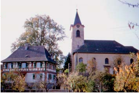
Abb. 18 a: Pfarrhaus und Kirche vor dem Umbau (Die Aufnahme entstand zwischen 1954 und 1964)
