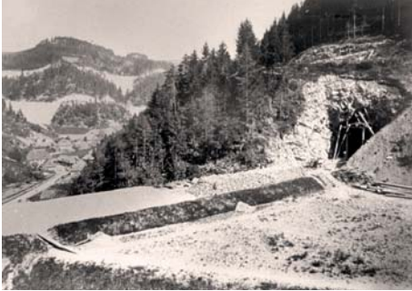
Abb. 6: Bau des Großhaldetunnels bei Triberg, unteres Portal, um 1870. – Generallandesarchiv Karlsruhe G Technische Pläne II Eisenbahn 3 Nr. 33 (10)
