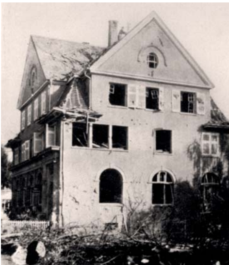
Das Volksbank-Gebäude nach dem Luftangriff am 28. September 1944
