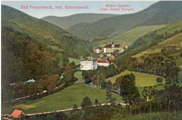
Abb. 3: An dieser idyllischen Stelle bei Freyersbach hatten sich die Bürgerwehren von Oppenau und Bad Peterstal am 22. August 1843 zum Empfang des Festzugs aufgestellt.
