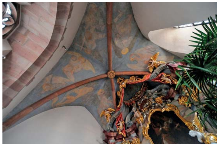
Abb. 3: Der barocke Altar steht sehr eingengt unter den mittelalterlich ausgemalten Kappen des alten Chors im heutigen Turmunterbau in Oberachern.
