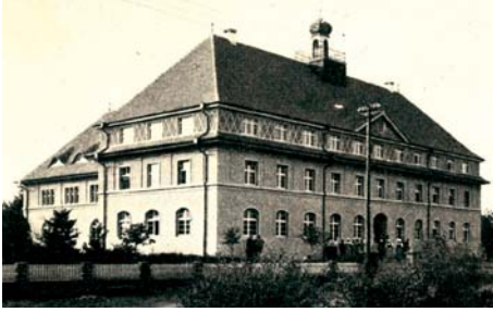
Abb. 2: Gemeindehaus St. Jakob, Schutterwald
