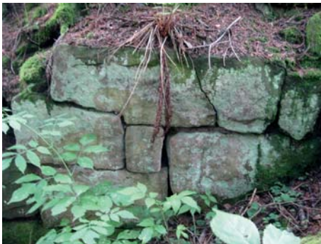
Abb. 5: Willenburg. Mauerdetail mit der Einpassung von Quadern.
