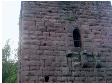
Abb. 16: Schilteck. Ostseite (Hofseite) des Bergfrieds. Hocheingang mit Konsolsteinen und Resten des Dachanschlages des ehemaligen hölzernen Zugangs.
