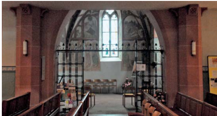
Abb. 7: Der Chorbogen in Loffenau überschneidet den Emporenboden.
