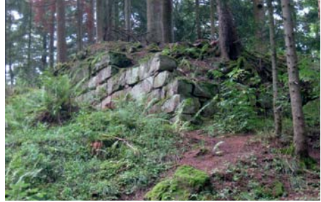
Abb. 6: Willenburg. NO-Ecke außen am Hang.
