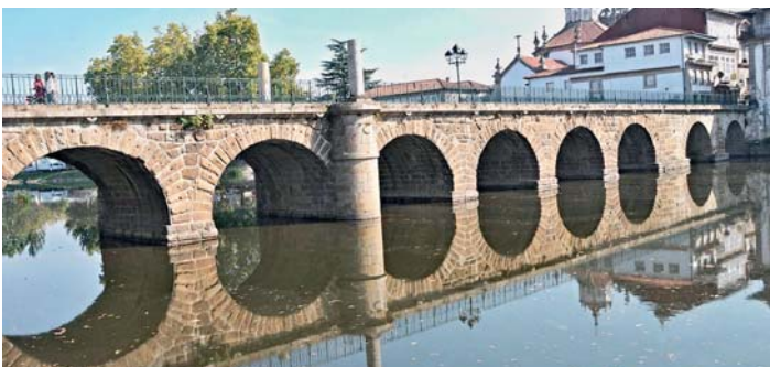
Abb. 14: Die römische Brücke über den Rio Tamega nach Chaves. Auf ihr stehen zwei Kopien des Meilensteines. Der Stein wurde 1980 in in der Nähe im Flussbett gefunden
