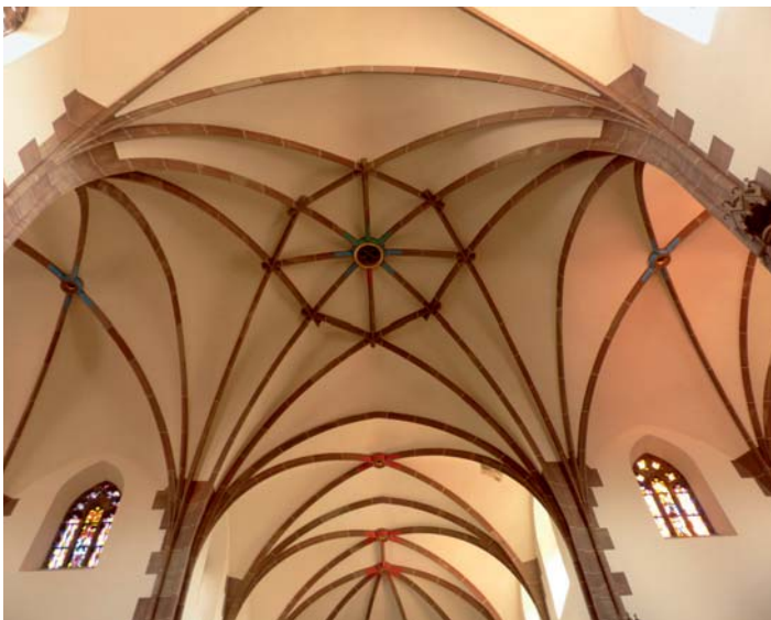
Abb. 15: Das Stern- gewölbe der neugoti- schen Vierung hat Ähnlichkeiten mit dem Gewölbe des alten Chors von Ottersweier.
