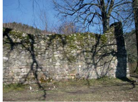
Abb. 3: Die hofseitige Fassade des Turmes; besonders im mittleren Abschnitt ist im unteren Teil noch Kleinquadermauerwerk erhalten.
