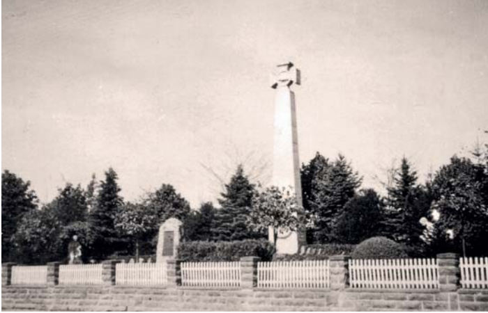
Abb. 8: Das Muschelkalkkreuz auf dem Ehrenfriedhof wurde eigens für den Heimattag errichtet.
