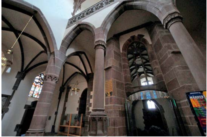
Abb. 12: In Ottersweier liegen die Wasserschläge der Strebe Pfeiler des ehemaligen Hauptchors im Innern.
