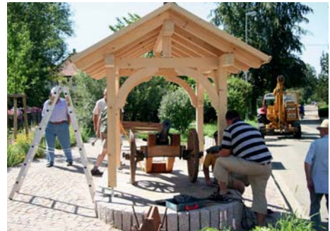
Letzte Arbeiten bis zum Richtspruch
