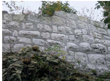
Abb. 4: Die restaurierte Ringmauer besteht aus Buckelquadern aus Kalkstein
