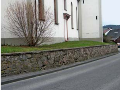
Stützmauer an der Bohlsbacher Straße, 1851, erstellt aus dem Steinbruch vor Wiedergrün; musste 1931 erneuert werden, unter Verwendung des vorhandenen Granitgesteins (Foto: hlh)
