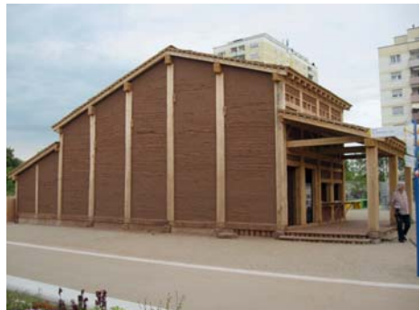
Streifenhaus (Längsseite mit Holzständern und Lehmverputz)
