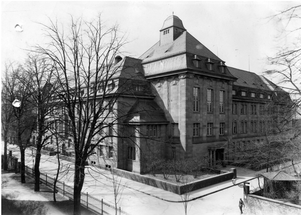
Abb. 8: Das Gebäude des Evangelischen Oberkirchenrats nach seiner Fertigstellung, Foto um 1907 (Landeskirchliches Archiv)
