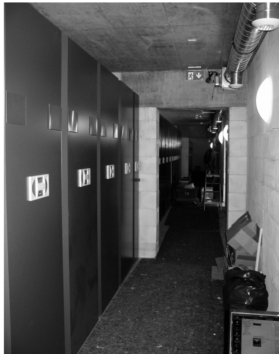
Abb. 33: Neubau Magazin: Einbau der Regalanlage
