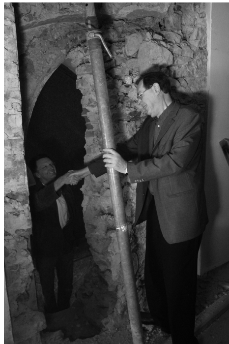
Abb. 24: Stiftskirche Mosbach, Mauerdurchbruch am 9. Mai 2008: Erster Handschlag zwischen Monsignore Klaus Bader (rechts) und Dekan Dirk Keller. Foto: Uwe Krück, Mosbach
