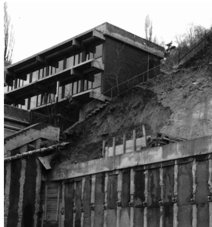
Abb. 13: Hangarbeiten beim Bau des Theologischen Studienhauses an der Neuenheimer Landstraße in Heidelberg (Landeskirchliches Archiv)
