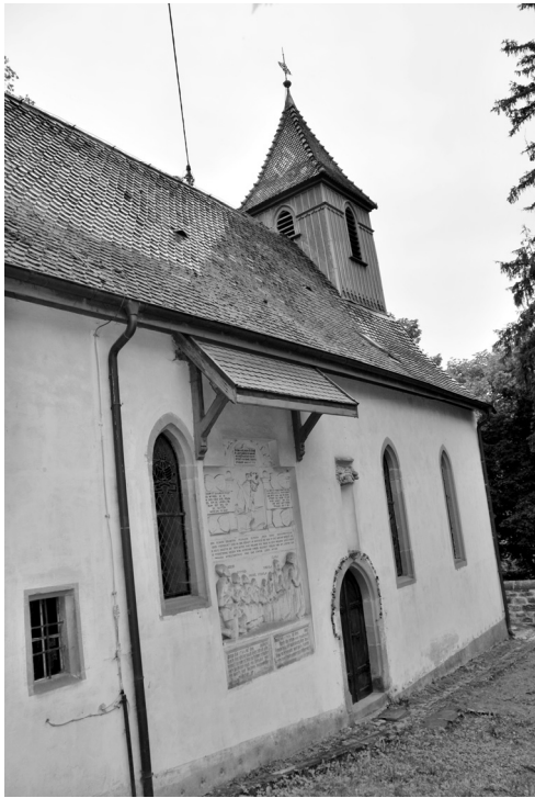
Abb. 7: Die Kirche von Neckarmühlbach, Außenansicht (Foto: Bernolph Frhr. von Gemmingen-Guttenberg)
