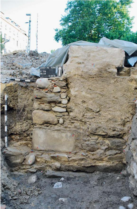
**Abb. 13:** Rechts im Bild ist das angesetzte Mauerwerk zu sehen, in der Mitte der verputzte Bereich. Links davon ist das Mauerwerk wohl nach Aufgabe des Gebäudes mit Teil- oder Ganzunterkellerung im Westen abgebrochen worden und mit einem stumpfen Ende versehen worden (Foto: RPS).
