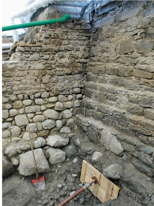
**Abb. 7:** Nördliches Kaufhausfundament (rechts) mit den deutlich im Fundamentmauerwerk zu erkennenden Stufen. Links: Stadtmauer. Blick in Richtung Südost (Foto: RPS).
