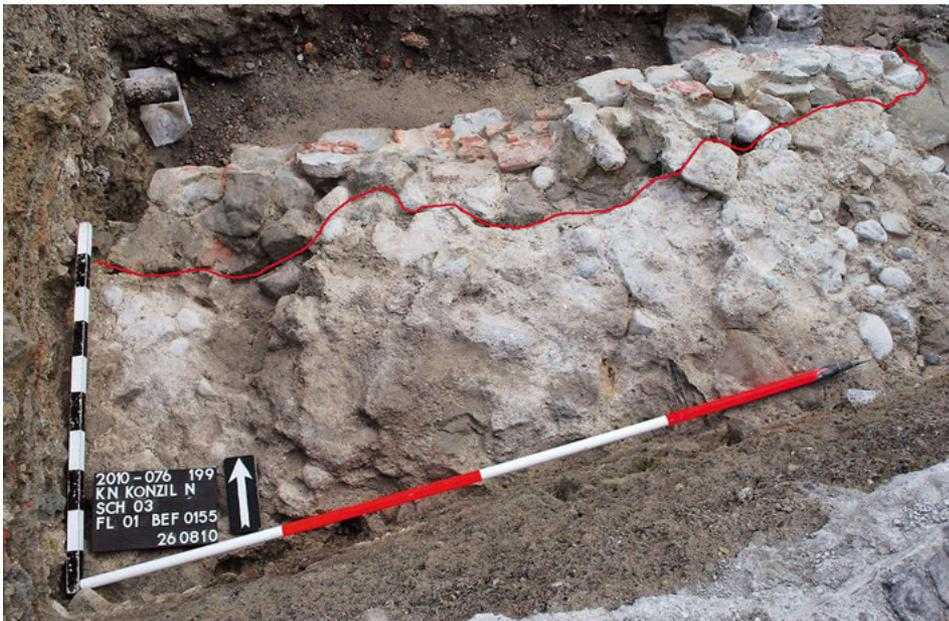
**Abb. 16:** Fotoaufnahme des Ausbruches von oben. Die durch ihre rote Farbe erkennbaren Ziegel und Backsteine entsprechen dem Bereich des neu aufgemauerten Bogenansatzes. Der Verlauf des Ausbruches ist mit der roten Linie nachgezeichnet (Foto: RPS).
