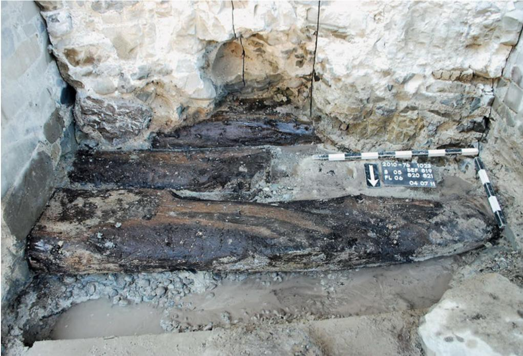
Abb. 9: Drei der insgesamt 5 Schwellbalken unter dem nördlichen Fundamentmauerwerk (Foto: RPS).
