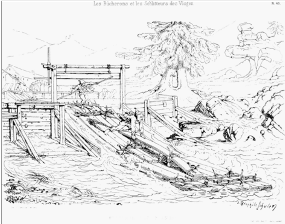
Abb. 8: Bretterfloss bei der Durchfahrt durch eine Flossgasse in den Vogesen. Die aufgezogene Schütze gibt die Schussrinne frei; der vordere Flösser sucht das Eintauchen des Flosskopfs ins Unterwasser zu verhindern. Zeichnung Th. Schuler 1857 (aus Michiels und Schuler, 1978)
