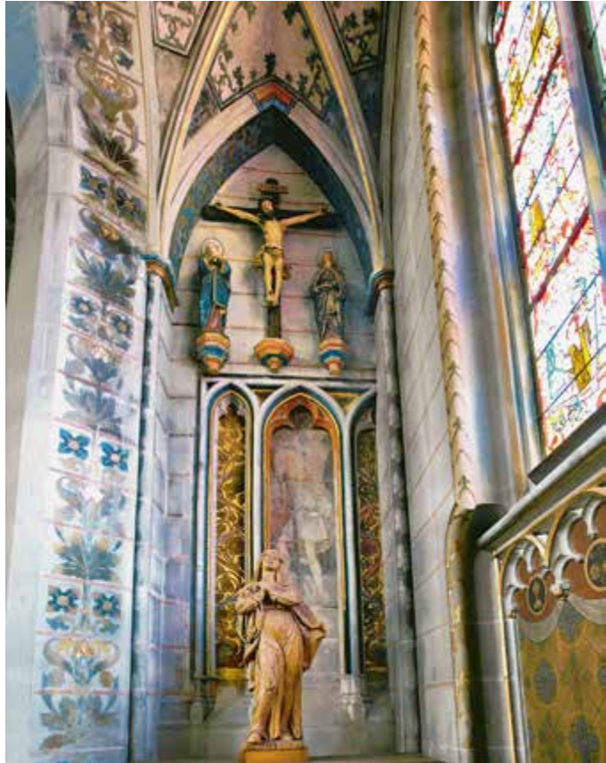
Abb. 8: Innerhalb der östlichen Kapelle sichtbare Blendgliederung von der früheren Außenseite des südlichen Querhausarms. Hinter der Kreuzigungsgruppe verbergen sich die Reste eines abgeschlagenen Kaffgesimses und ein Teil einer zugesetzten großen Fensteröffnung.
