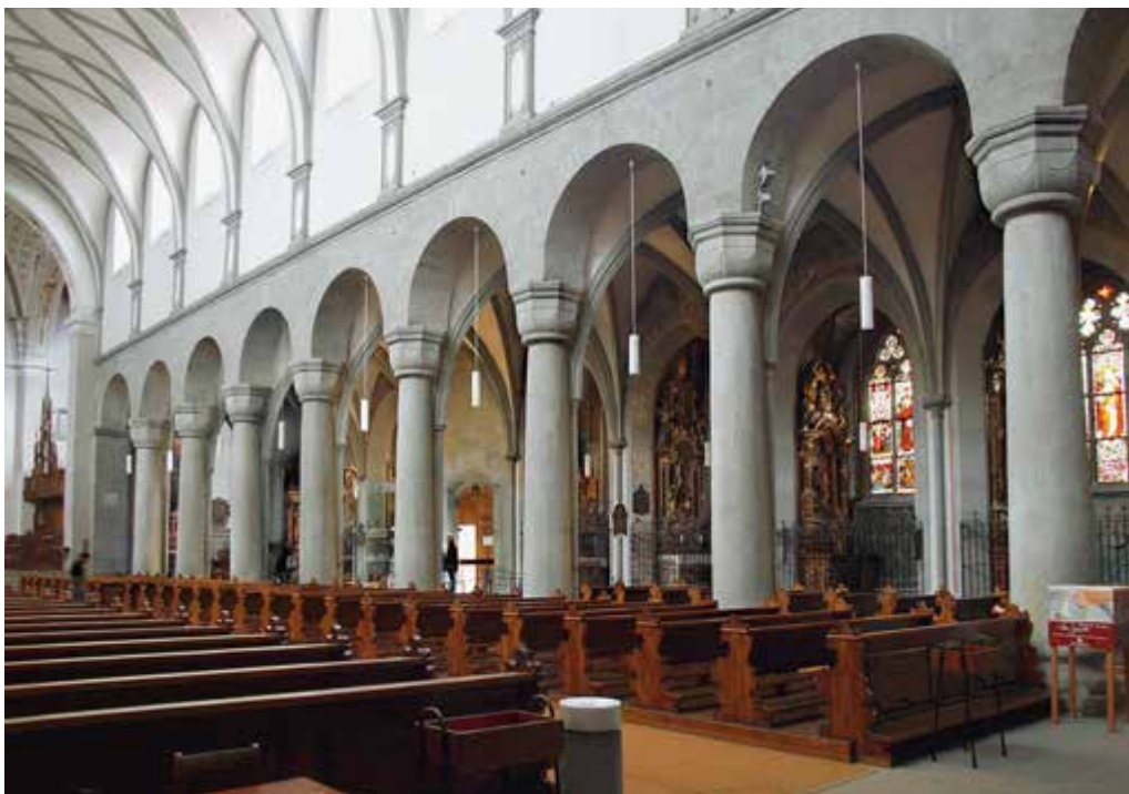
Abb. 2: Hinter der südlichen Langhausarkade die Scheidwand – früher die Außenwand – mit hohen spitzbogigen Öffnungen zu den Kapellenräumen und der Portalöffnung dazwischen.
