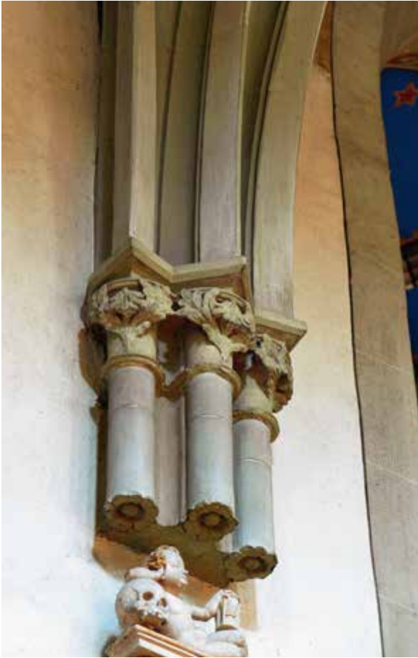
Abb. 13: Dreiteiliges Dienstbündel an der früheren Außenwand des nördlichen Seitenschiffs zwischen dem zweiten und dritten Joch von Osten, von dessen Rosetten am unteren Ende die Blattspitzen leicht vorstehen.
