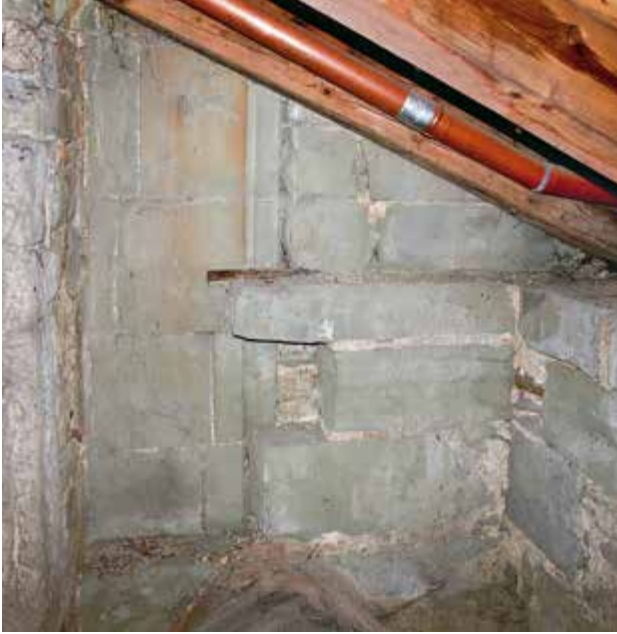
Abb. 9: Im Dachraum einsehbare profilierte Laibung einer vermauerten großen Spitzbogenöffnung innerhalb der Westwand des südlichen Querhausarms.
