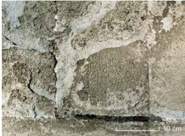
Abb. 39: Bauzeitliche Oberflächenbearbeitung im höheren Bereich der vierten Kapelle von Westen mit im Schachbrettmuster rechtwinklig zueinander gesetzten Stelzhieben.
