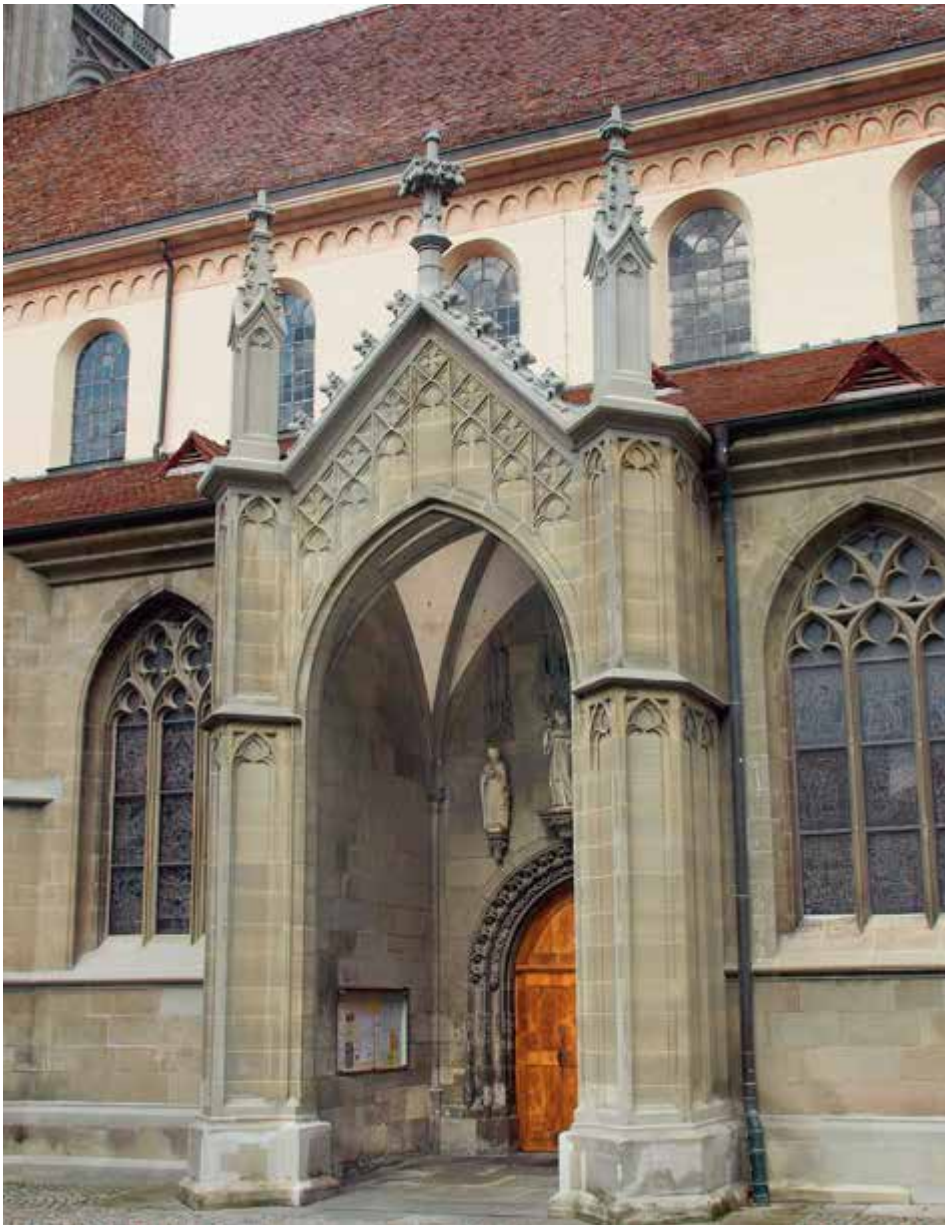
Abb. 35: 1854 in gänzlich anderer und verkürzter Form neu errichtete Fassade der Portalvorhalle, bestehend aus Spornfeilern, die in Fialen übergehen, und einem Wimberg mit Blendmaßwerk über der spitzbogigen Öffnung.
