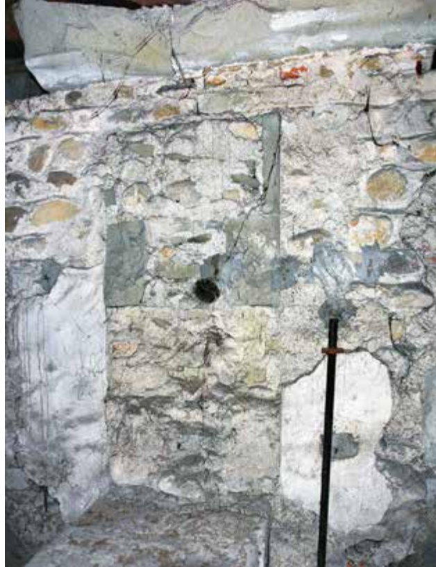
Abb. 14: Spuren eines Strebepeilers an der früheren Außenwand, sichtbar im Dachraum über den Südkapellen zwischen der zweiten und dritten Kapelle von Osten. Unten Abdruck zwischen seitlich anstoßendem Wandputz, darüber abgeschlagene Werksteine der Verdachung, ganz oben Reste des Traufgesimses aus dem 13. Jahrhundert.
