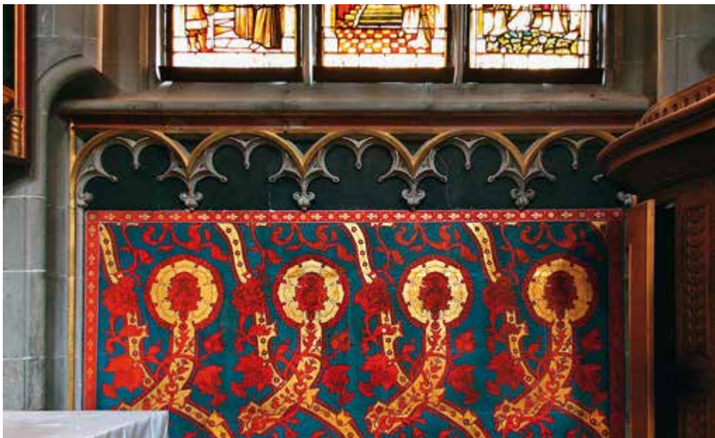
Abb. 11: Blendmaßwerkfries innerhalb einer Flachnische, zusammengesetzt aus fünf genasten Halbpässen mit Lilien. Der Fries findet sich nur in den drei Kapellen östlich des Portals, hier in der Gebhardkapelle.
