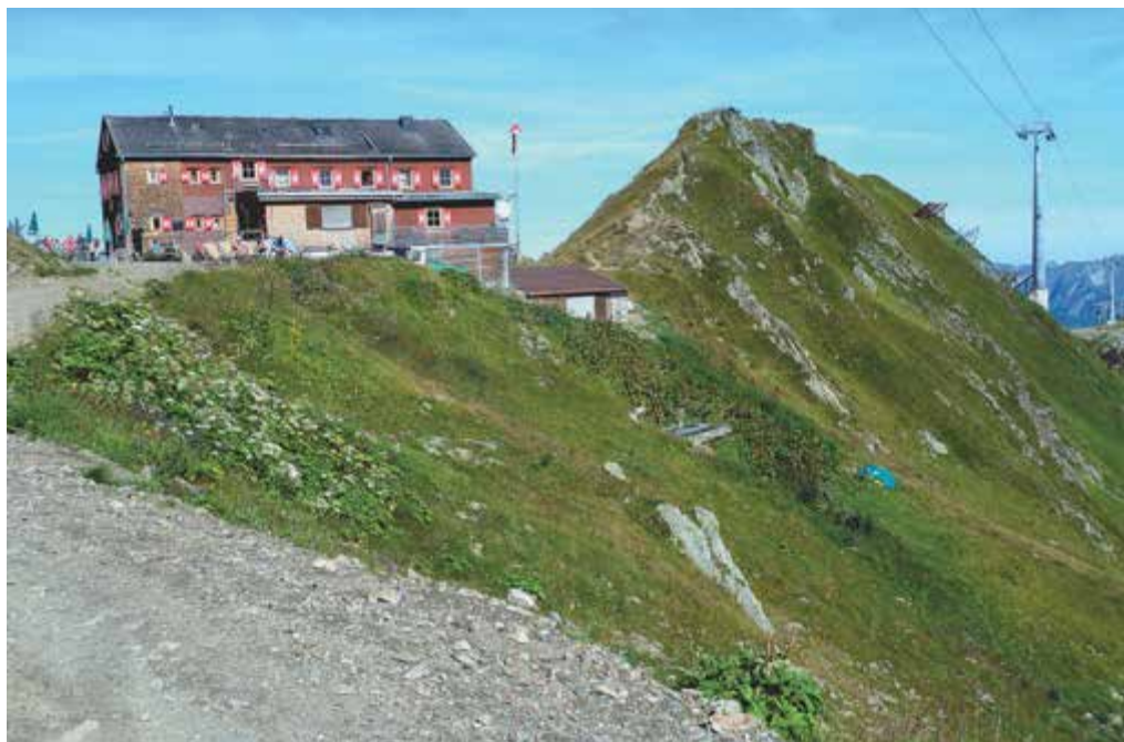
Abb. 12: Die lange Zeit nur auf Bergpfaden erreichbare Wormser Hütte liegt heute inmitten des Schrunser Skigebiets. Sie ist mit einer Versorgungszufahrt und Sesselbahn, im Winter auch neu hinzugekommenen Seilbahnen erschlossen
