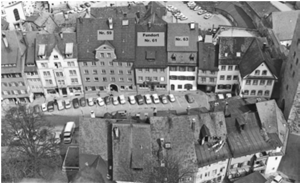
Abb. 17: Die obere Marktstraße aus der Vogelschau, 1972. Der Fundort Haus Nr. 61 mit Rückgebäude beherbergte bis 1530 die Handels-Zentrale der Humpisgesellschaft, danach bis heute den Gasthof Zum Mohren.
