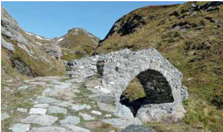
Abb. 9: Steinbogenbrücke auf der Septimer-Südseite, die 1991 im Rahmen der Restaurationsarbeiten erstellt wurde (Foto H. Tiefenthaler)
