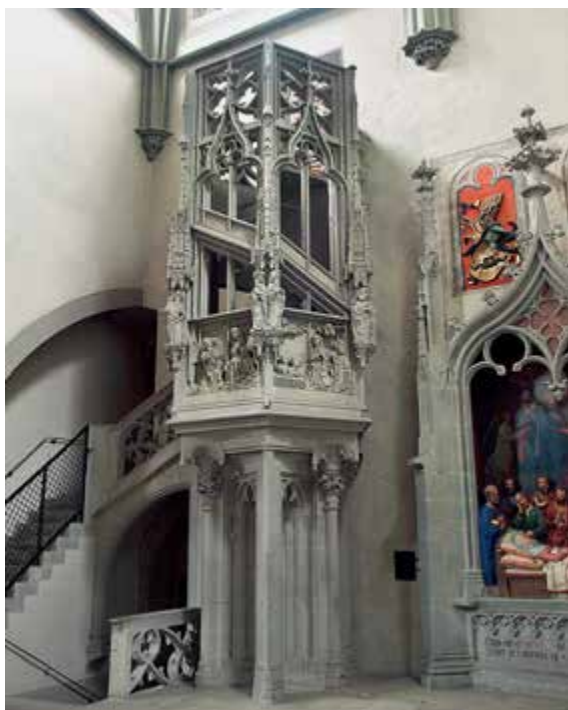
Abb. 1: Der Schnegg im Thomaschor mit einer Wendeltreppe im hochliegenden Gehäuse, insgesamt 8 m in der Höhe messend.
