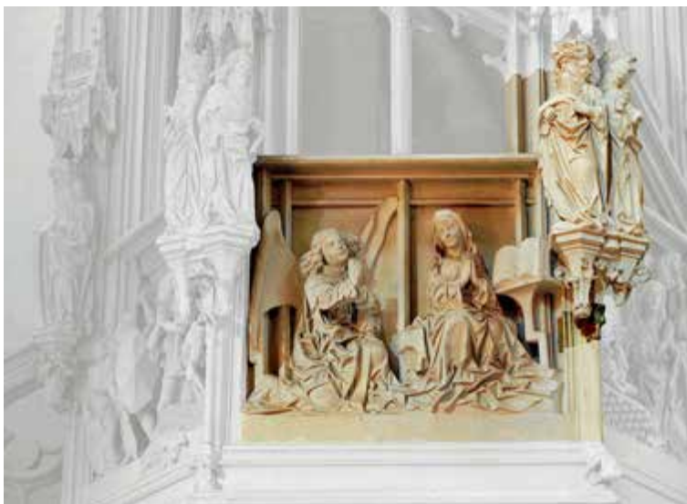
Abb. 3: Die figürlich gestalteten Brüstungsplatten – hier Mariae Verkündigung – bilden zusammen mit dem angrenzenden Eckpfeilerabschnitt, den Konsolen und zwei Prophetenfiguren ein einziges großes Werkstück (grafisch hervorgehoben), so dass sich Bildszenen und rahmende Profile vielfach überlagern konnten.
