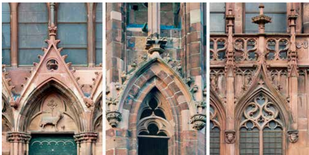
Abb. 6: Entwicklungslinie vom giebelartigen Wimperg über einem Spitzbogen, gefolgt von der Verschmelzung des Wimpergs mit dem Spitzbogen bis zum Hochziehen der Spitze zu einem steilen Kielbogen; Aufnahmen vom Freiburger Münster, da am Konstanzer Münster keine anschaulichen Beispiele aus dem 14. Jahrhundert zu finden sind: Lammportal um 1260; südlicher Hahnenturm 1340-er Jahre, Heilig-Grab-Kapelle, 1578.
