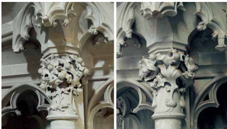
Abb. 2: Kapitele des Unterbaus mit hinterschnittenem, aus Zweigstücken und Knollen wachsenden Laubwerk.
