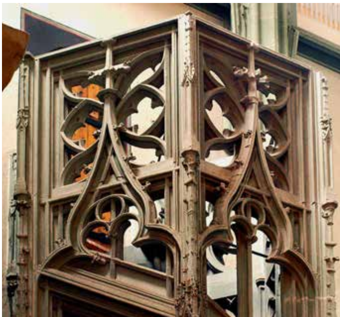
Abb. 5: Das Motiv des Schulterzwiebelbogens am Schnegg: Auf Kragbögen sitzt ein eingezogener und mit Krabben besetzter Kielbogen, der die Form einer Zwiebel annimmt.
