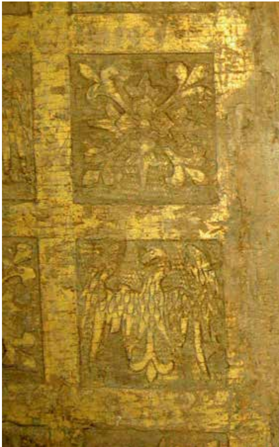
Abb. 9: Adler und Kreuzblume, fein reliefhaft in Stuck ausgeführt und auf blauem Grund vergoldet, ehemalige Rückwand des Gnadenbilds (Ausschnitt).
