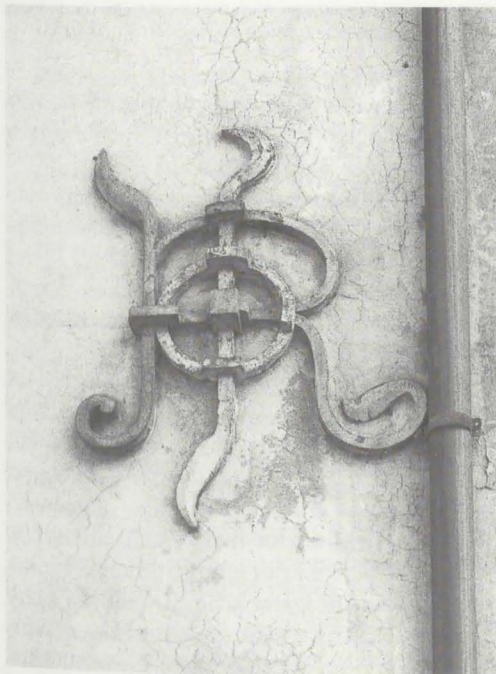
Die Eisenklammern an der Nordfront wurden auf Wunsch des Besitzers Reinhart Härle in der Form seiner Initialen R und H angebracht
