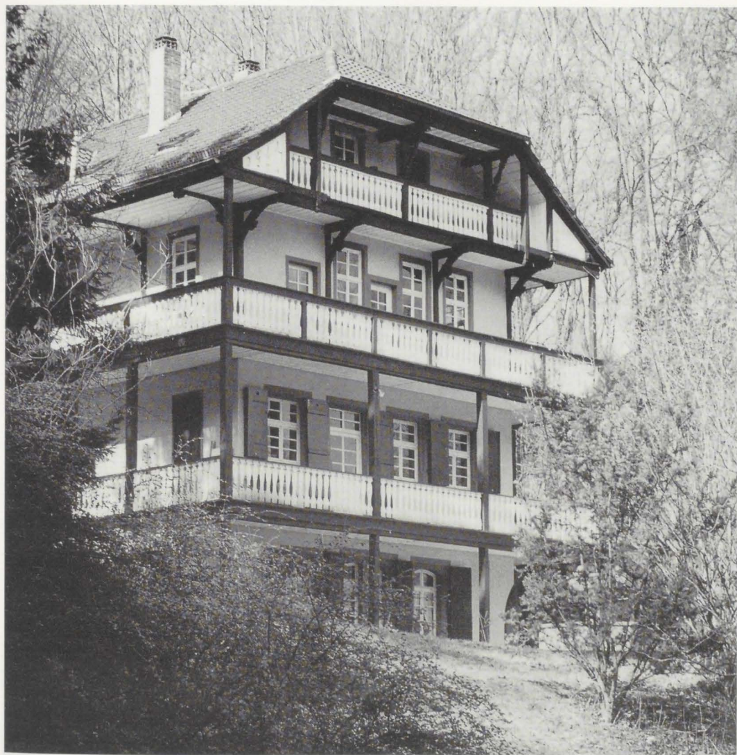
Die Gaststätte „Zum Wolfsbrunnen“ am Ende des Waldtales in Heidelberg-Schlierbach. Das Gebäude wurde 1822 errichtet.
