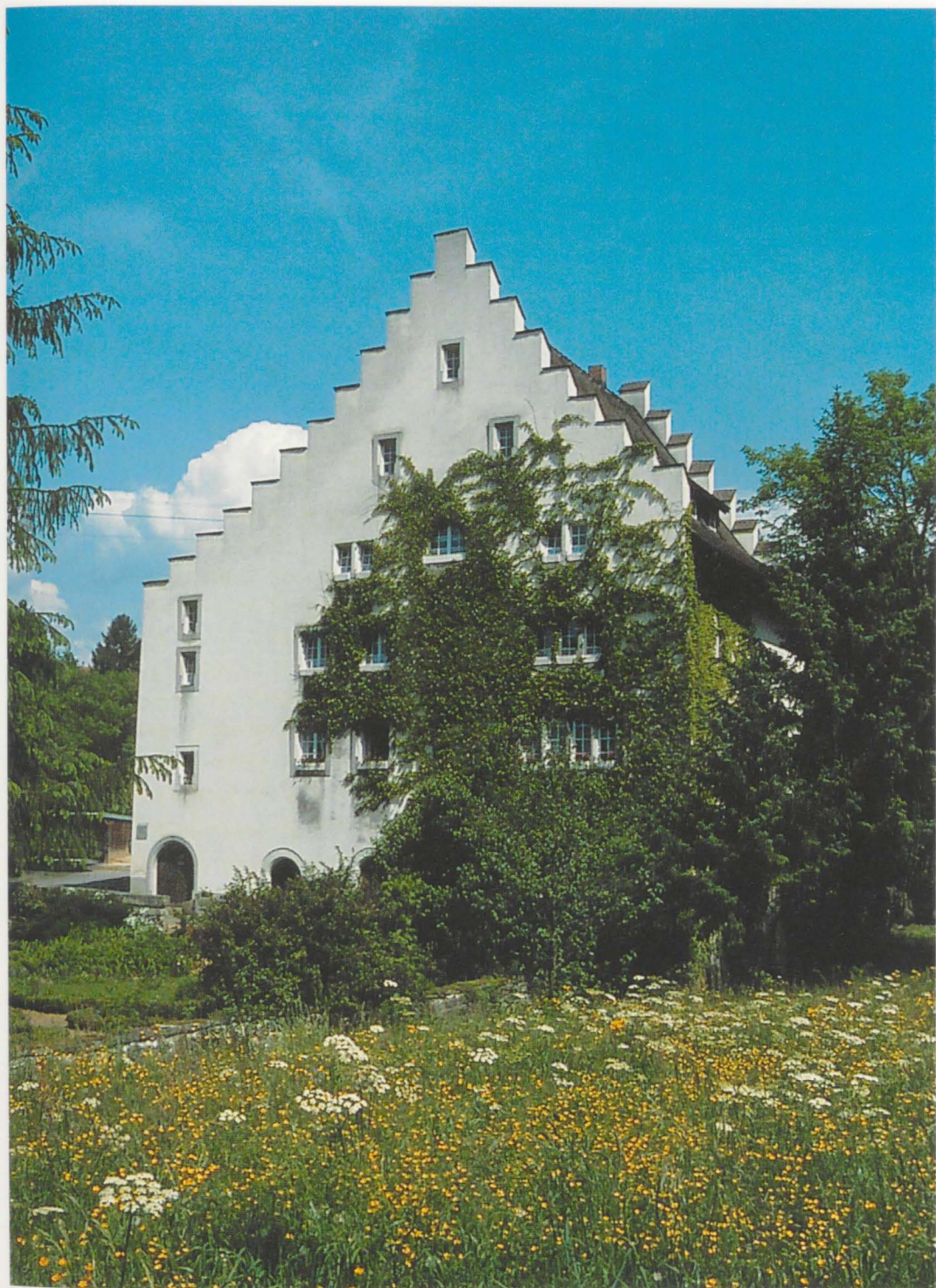
Kaum eine andere Mühle in unserer Heimat ist so geschichtsträchtig wie die in Unteralpfen. Besonders die Besitzer Adam Tröndlin und sein Sohn Josef haben großes Ansehen genossen. Vor einigen Jahren, bei der Gesamtnovierung des Gebäudes, ist auch der Treppengiebel wieder dem gotischen Baustiel angepasst worden. Im Untergeschoss befindet sich heute ein Mühlenmuseum.
