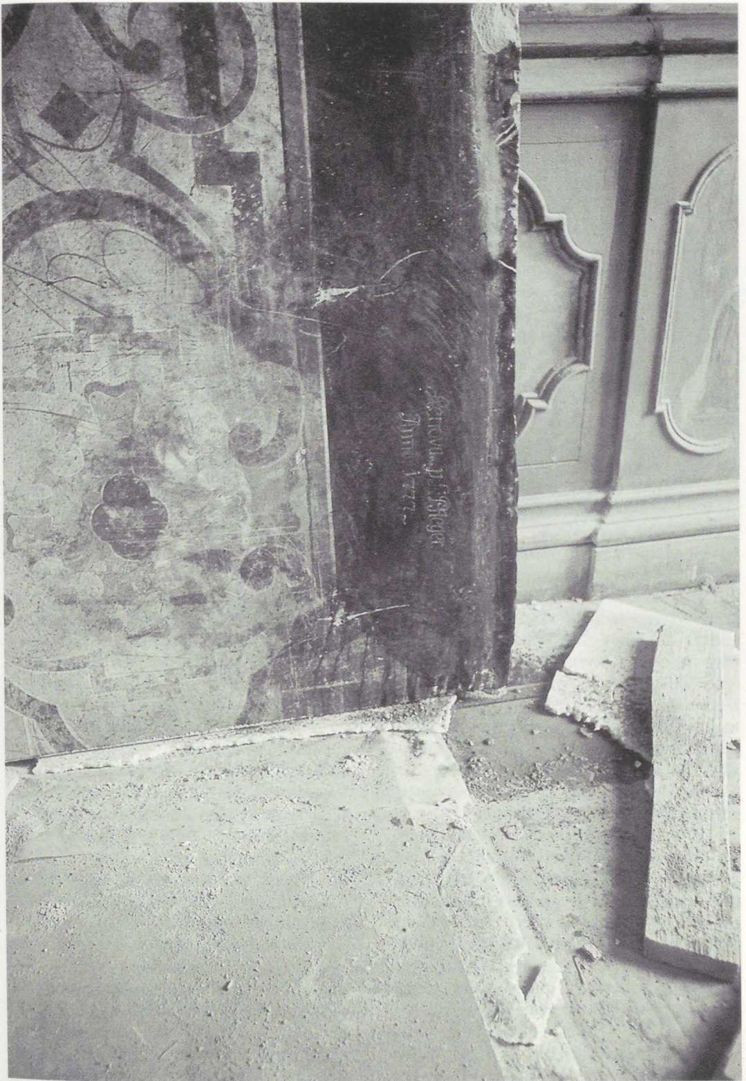
Ausgebauter Scagliolaboden mit Restaurierunginschrift von 1777
