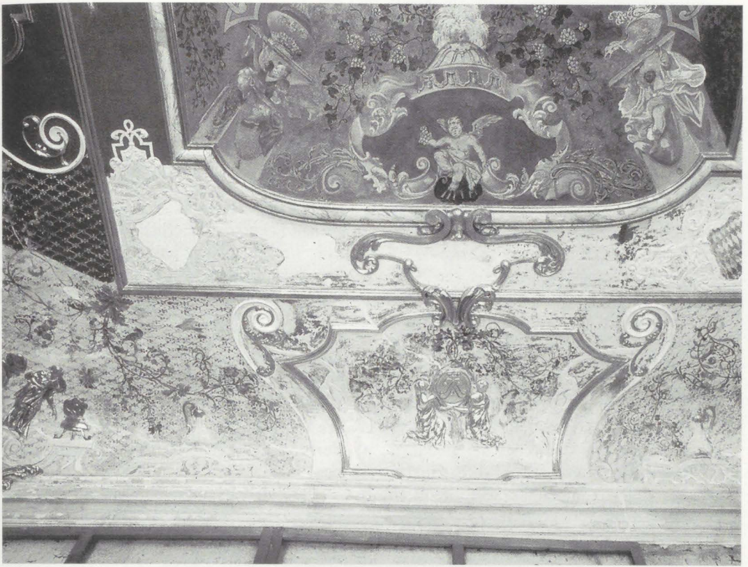
Probe für eine Deckenrestaurierung vor Entdeckung der Bleiweißschwärzung
