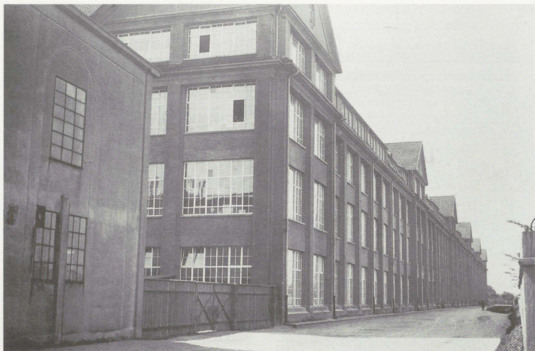
Abb. 9: Die Westfassade des Hallenbaus an der heutigen Lorenzstraße vor dem Zweiten Weltkrieg
