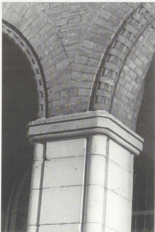
Abb. 14: Arkadendetail der Schlossplatz-Fassade, Kämpferzone mit flacher Kapitelplatte in Haustein, Bogenanfänge mit einfacher Formstein-Verzierung
