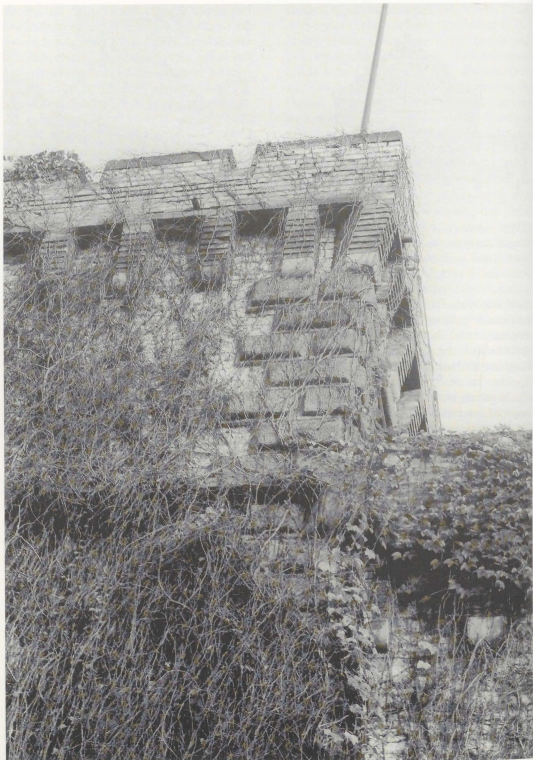
Abb. 15: Blick auf Ecksituation des Torbaus mit Rustikaquaderung, gemauerten Konsolen der Auskragung und Brüstung des Umgangs
