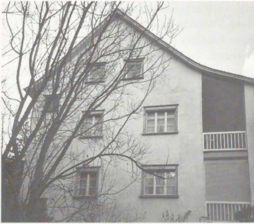
Fassadenansicht von Osten, Zustand 2001
