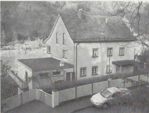
Wohnhaus in Heidelberg für Speers Schwiegereltern, Süd-West Ansicht, Entwurf: Albert Speer 1929, Zustand 2001
