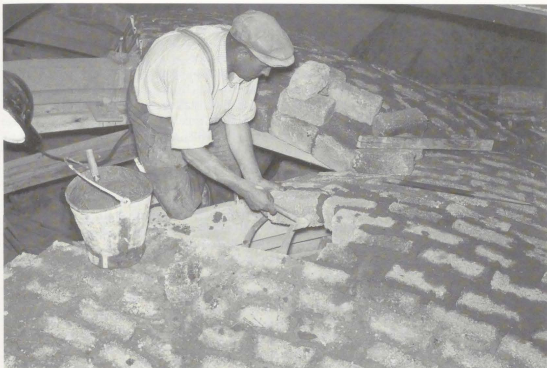
Die Ausschalung des Gewölbes
