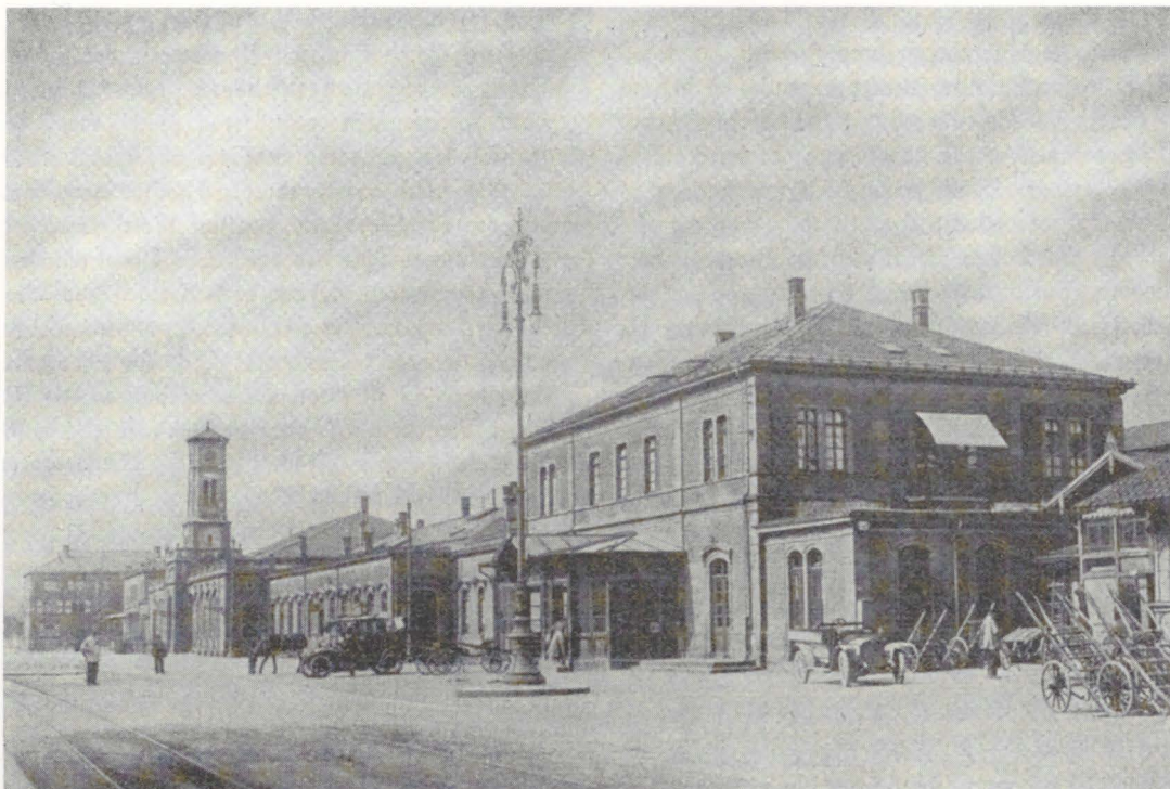
Alter Badischer Bahnhof Basel. Empfangsgebäude von 1862.
