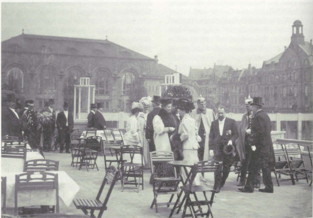
Die Gesellschaft auf der Terrasse des Hauptrestaurants am Wasserturm
