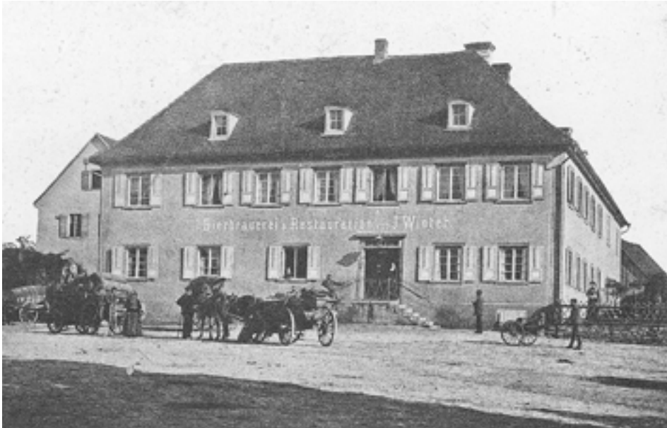
Abb. 2: Hotel Winter vor dem Umbau
