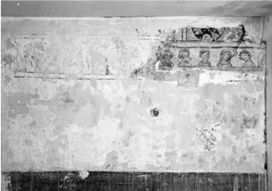
Abb. 21: Fundsituation Marktstr. 61 mit der später eingezogenen Decke, die ursprünglich in 4 Meter Höhe anzusetzen ist. Hier zeigt sich, dass sich das Wandbild bis zum Ende des Raumes fortsetzte. Foto: Landesdenkmalamt Gudula Bock Nr. 139–71 im Stadtarchiv Ravensburg.
