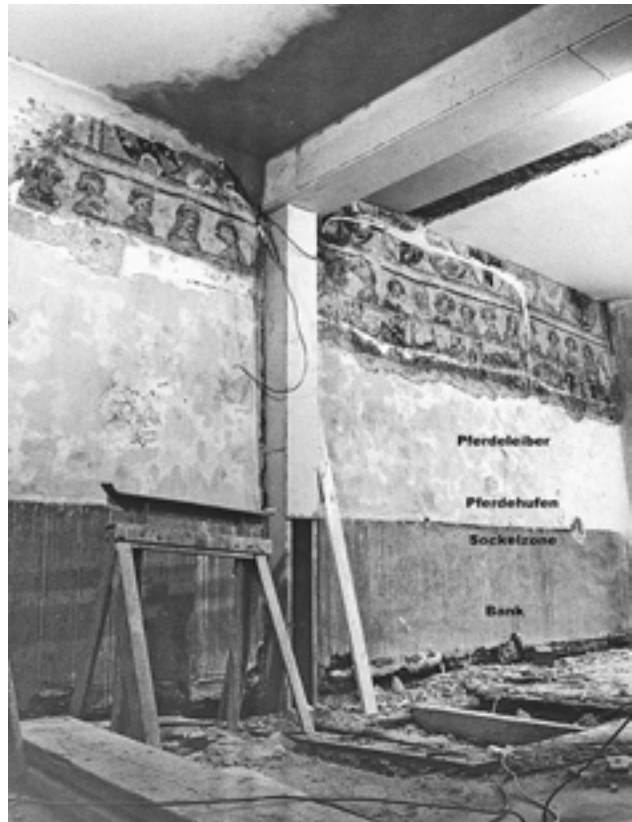
Abb. 4: Die Fundsituation im Gebäude Marktstr. 61 im Jahr 1972. Foto Reinhold Leinmüller, Stadtarchiv Ravensburg.
