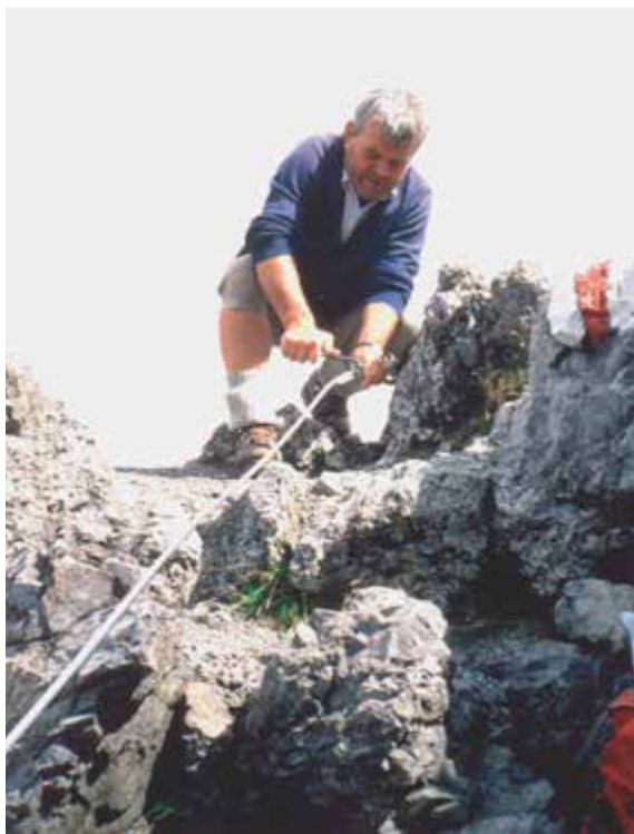
Abb. 10: Bruno Fink – von 1972 bis 1996 Landeswegwart der Sektion Vorarlberg – bei der Erneuerung einer Seilsicherung
