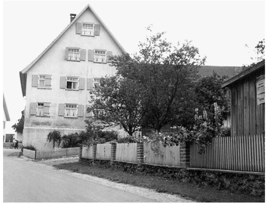
Gebäude Hürbler Straße 14, Reinstetten.
