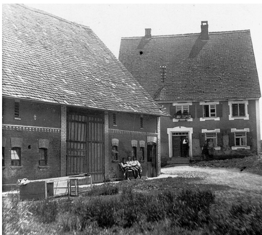
Gebäude Eichener Straße 5, Reinstetten.
