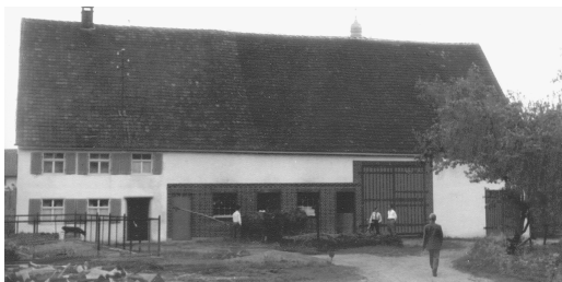
Gebäude Hürbler Straße 4, Reinstetten.
