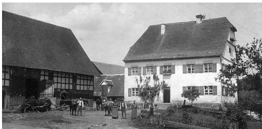
Gebäude Ochsenhauser Straße 22, Reinstetten.
