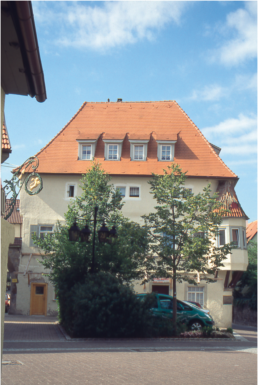
Das Gebäude Ostergasse 24 im Jahr 2003. Quelle: StadtA M. Foto: Petra Schäd.
