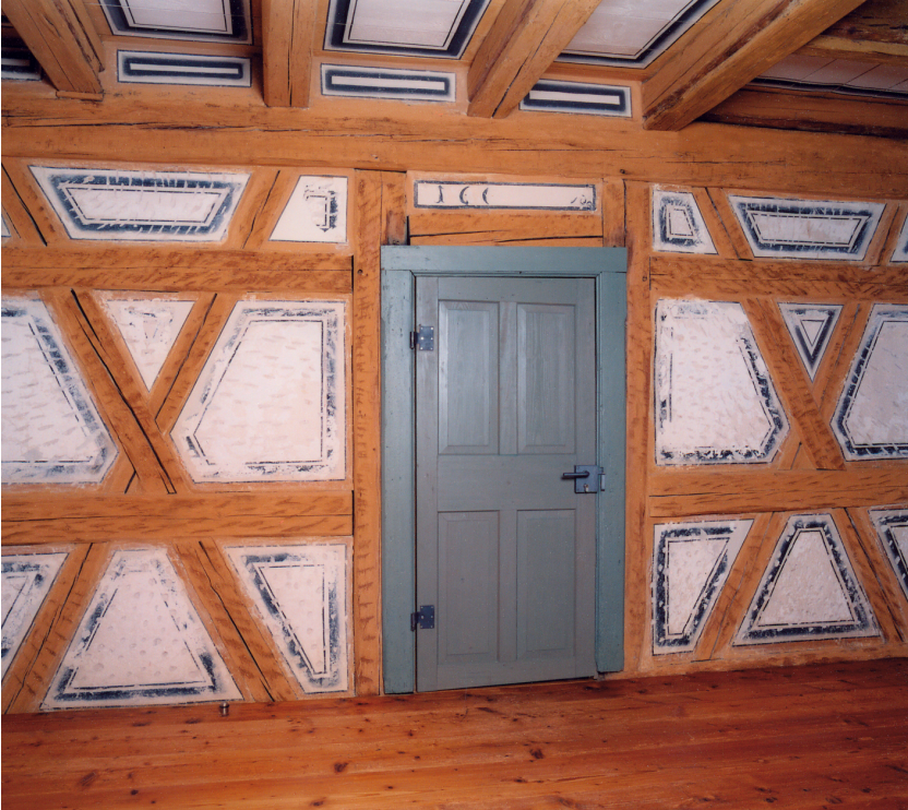
Bauzeitlich ausgemalte Kammer im 2. Stock.
