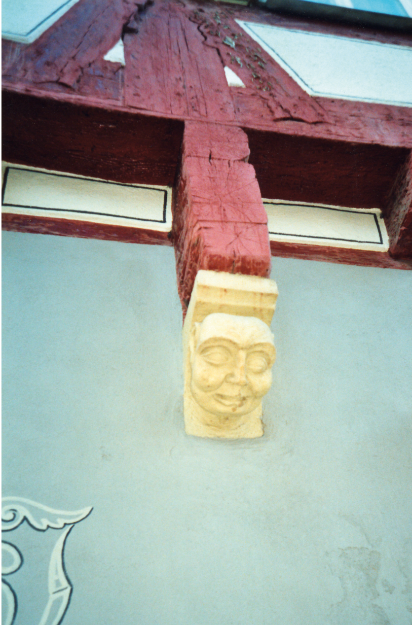
Neidkopf an der Hausfassade im Erdgeschoss.
