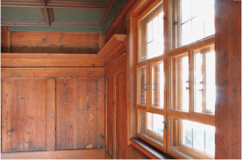
Die aus der Bauzeit erhaltene Tüfelstube im 1. Stock.
