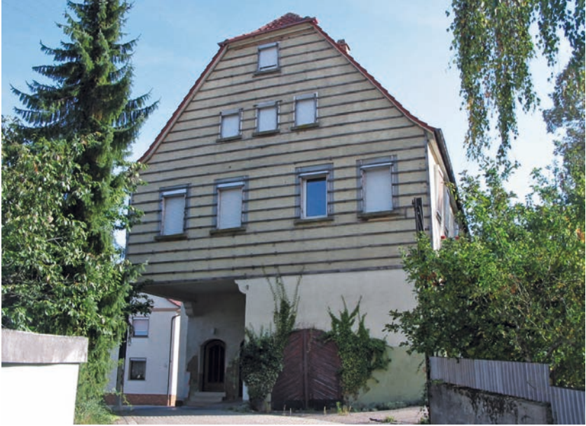
Westansicht des unscheinbaren Hauptgebäudes des Jägerhofs in Neckarwestheim.
