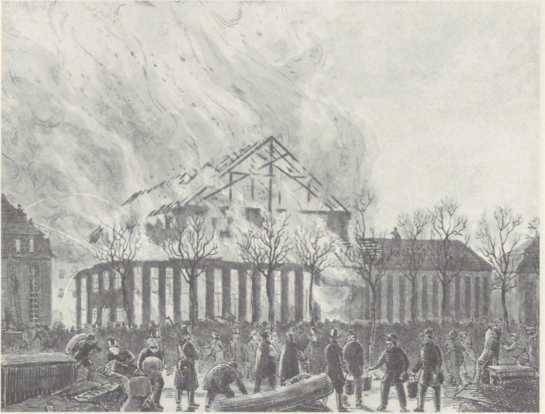
Das Hoftheater während des Brandes.
