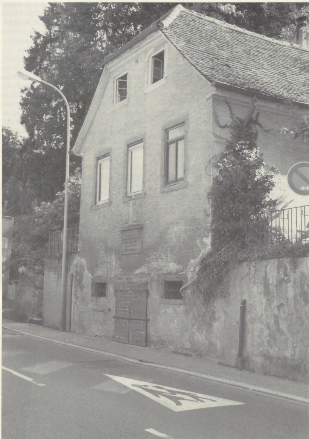
Gartenhalle „Zur Burg Windeck“; Weinheim, Müllheimer Talstr. 100; Zustand vor dem Abriß, um 1995
