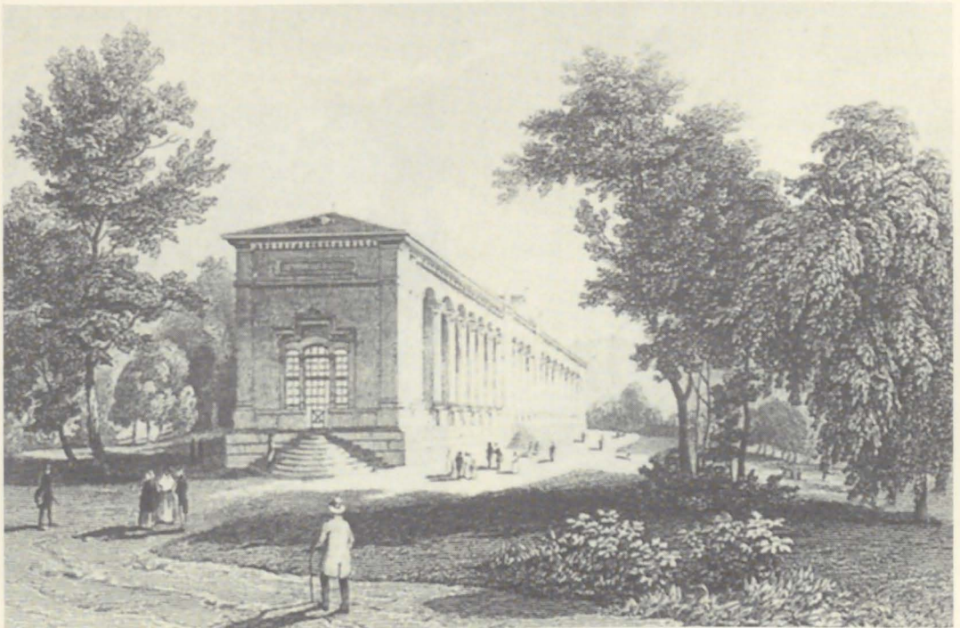
Trinkhalle in: Vues de Bade
