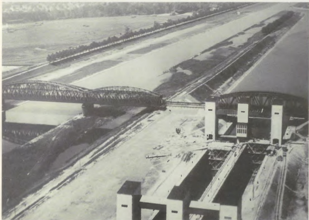
Neckarkanal bei Mannheim mit Riedbahnbrücke und der im Bau befindlichen, von Paul Bonatz entworfenen Hubschleuse, Luftaufnahme 1927
