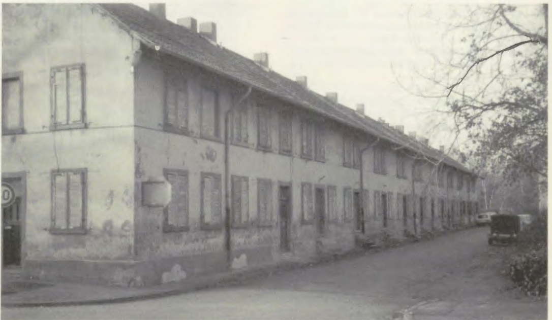
Der letzte verbliebene Arbeiterwohnblock der ehemaligen Spiegelkolonie
