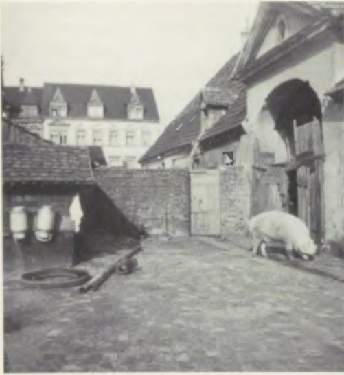
Anwesen „Stengelhofstraße“ mit Toreinfahrt und Trennmauer – 50er Jahre
