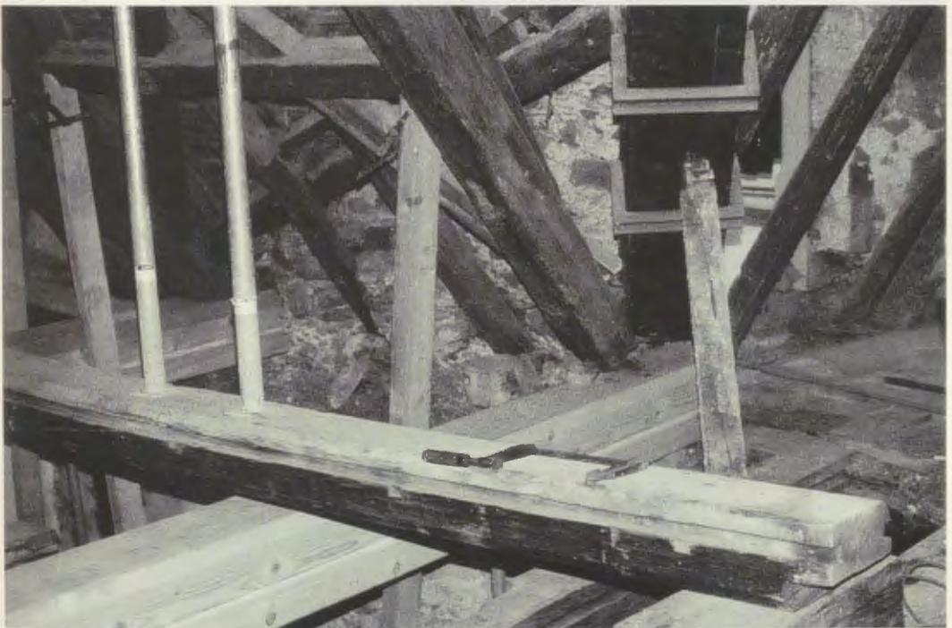
*Dachkehle zwischen Nordflügel und Mittelbau am Turm. Der verzogene und abgesackte Dachstuhl wird hochgepreßt und gerichtet, Rechts der mit Bohlen bandagierte und mit Stahlprofilen zusammengehaltene Kehlsparren.*
