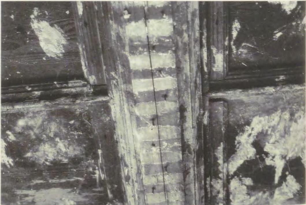
*Detail der Holzdecke des Mittelbaues nach der Freilegung. In Bildmitte der Deckenbalken mit Abzeichnungen von Verputzplatten. Von Profilleisten gefaßte Deckenbretter. Die weißen Flecken sind vom Verputz herrührende Kalkverätzungen.*
