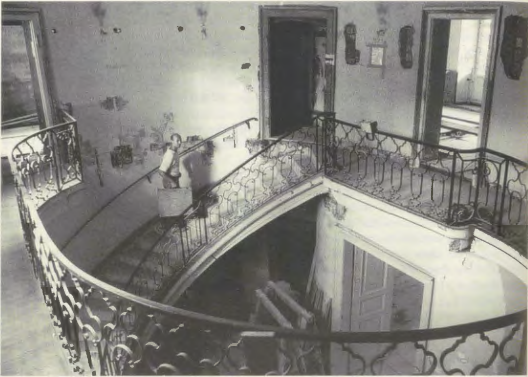
Das Treppenhaus während der Instandsetzungsarbeiten 1989–91
