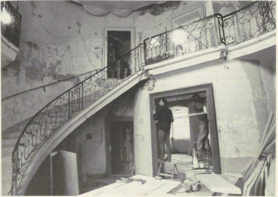
Das Treppenhaus während der Instandsetzungsarbeiten 1989–91
