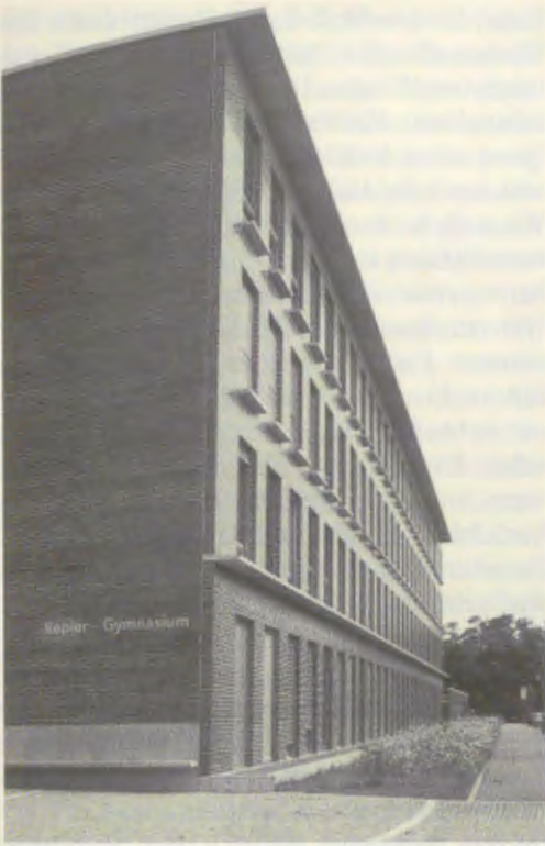
Rieselfeld – Neubau des Keplergymnasiums (Spycher)
