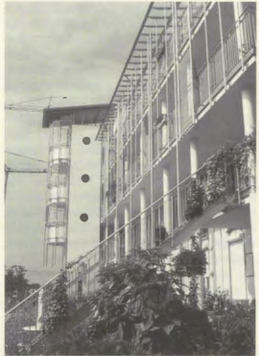
Rieselfeld – geförderter Mietwohnungsbau: Filigrane Vertikalgliederung
