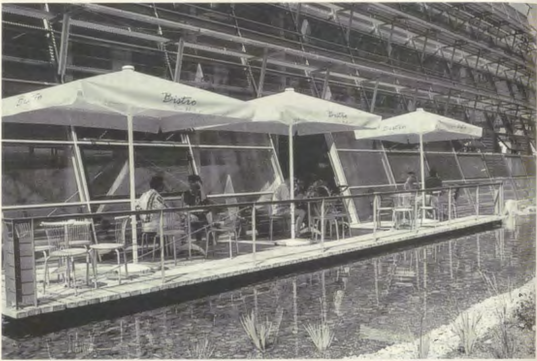
Bistro Solar-Fabrik: Sonnenterrasse
