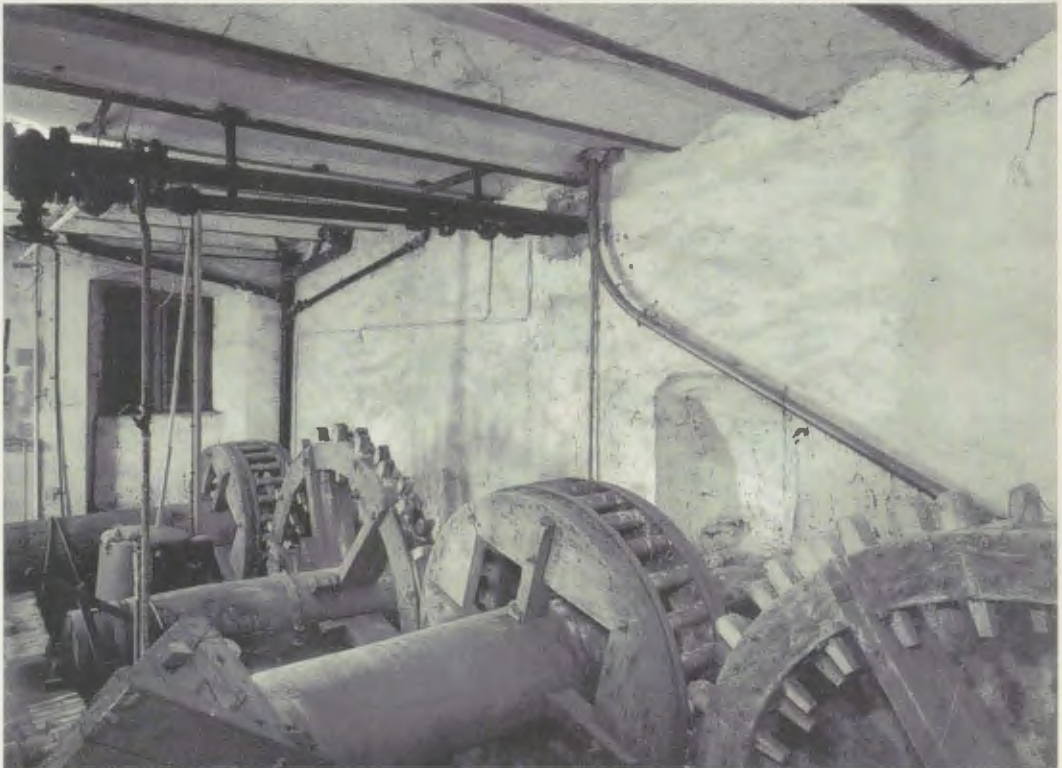
Mittels präzise gearbeiteter hölzerner Kammräder und Trillis wurde die Kraft auf die Pumpen übertragen. Heute ein trostloser Anblick.
