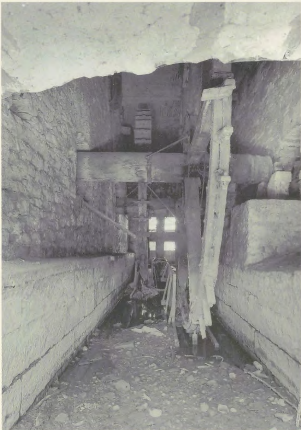
„Abgewrackt“, ihrer Schaufeln beraubt, vermitteln die beiden Triebräder mit ihren mächtigen Wellbäumen immer noch einen Eindruck ihrer einstigen Kraft. Die Sohle des Mühlbach-Durchflusses ist mit Unrat übersät.
