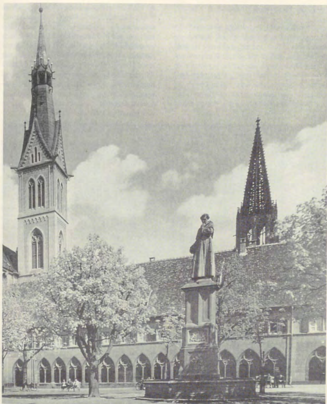
Nur der Ostflügel des Kreuzgangs des alten Franziskanerklosters blieb 1845 stehen – ein neuer Platz, ideal für ein Denkmal!
