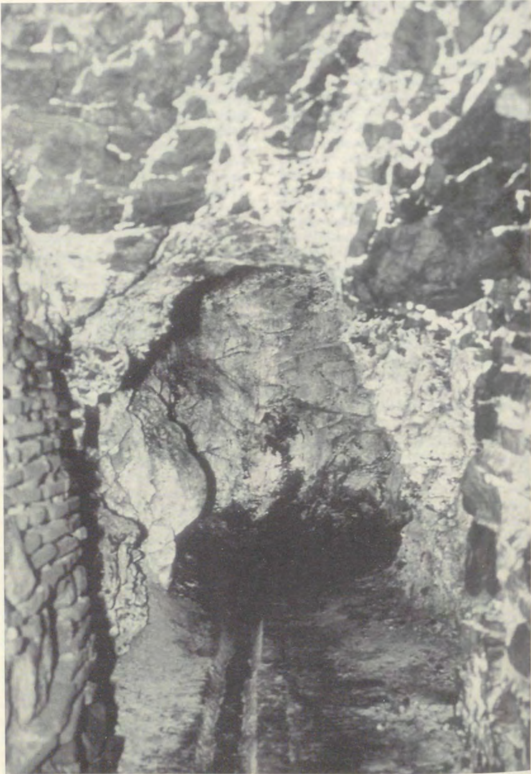
Fiederspalten an der Firste des Stollens.
