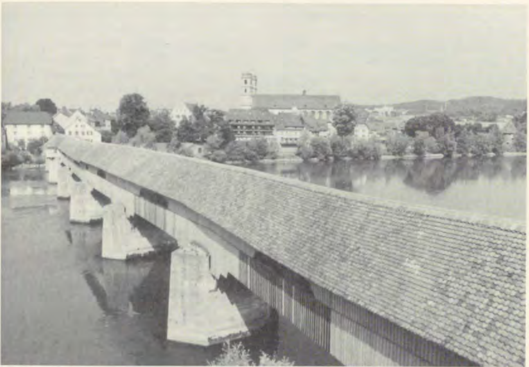
Die historische Rheinbrücke Bad Säckingen – Stein/Kanton Aargau. Vor 150 Jahren: Flucht- und Rückkehrweg der Revolutionäre.
