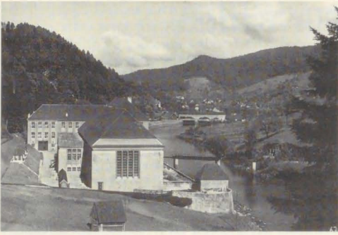
Strom für Baden aus Schwarzwälder Wasserkraft: Maschinenhaus und Schaltzentrale des „Murgwerks“ oberhalb von Forbach, fertiggestellt 1918 und erweitert in den Jahren 1924/26 mit dem Bau des „Schwarzenbachwerks“ (Badenwerk AG, Karlsruhe / Landesmuseum für Technik und Arbeit in Mannheim).
