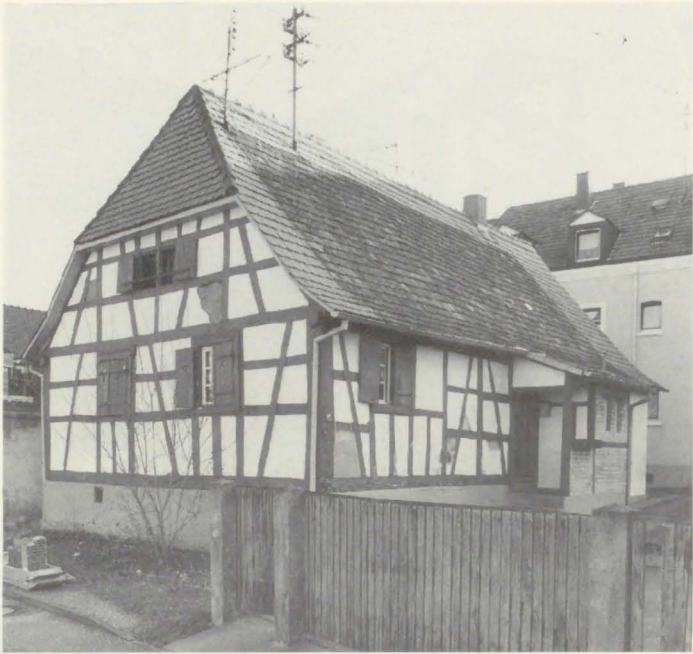
Pfarrstraße 15. Stattliches, ortsbildprägendes Fachwerkhaus in Daxlanden. Erbaut im 18. Jahrhundert. Dach mit typischem Krüppelwalme. Abbruchgenehmigung erteilt.
