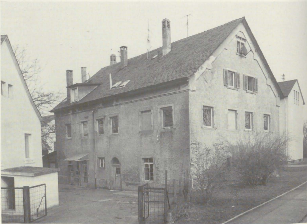
Untere Mühle, älteste der drei Durlacher Mühlen, die — obwohl vielfach umgebaut — zumindest in großen Teilen des Erdgeschoßes aus der Zeit vor dem Großen Brand 1689 stammt. Die Bausubstanz ist schwer geschädigt, das Erdgeschoß feucht und weitgehend ungenutzt. Eigentümer des Baudenkmals ist die Neuapostolische Gemeinde.
