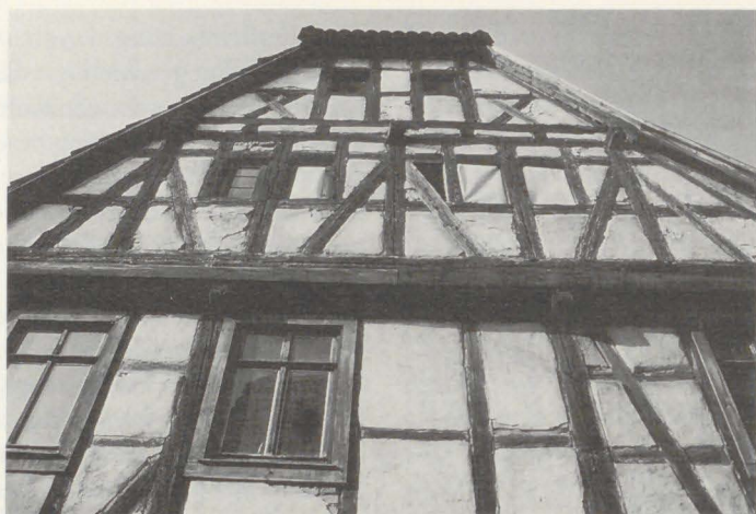
Pforzheim-Eutingen, Samenbäch 2. Fachwerkhaus, erbaut 1576/1600 (d), Straßengiebel (Kulturamt Pforzheim/UDB, 1992)
