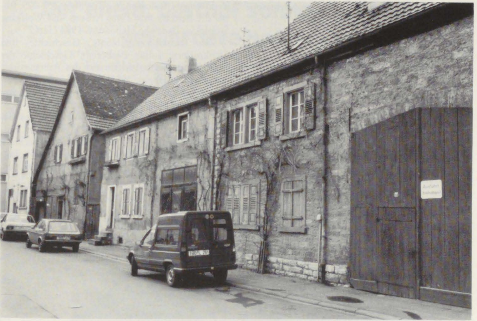
Tauberbischofsheim, Ringstr. 22–26, Ackerbürgerhäuser des 19. Jhds. im Bereich der geschleiften nordwestlichen Stadtmauer, abgebrochen, Aufn. 1988.
