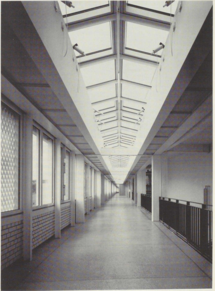
Innenansicht einer schrägen Rampe
