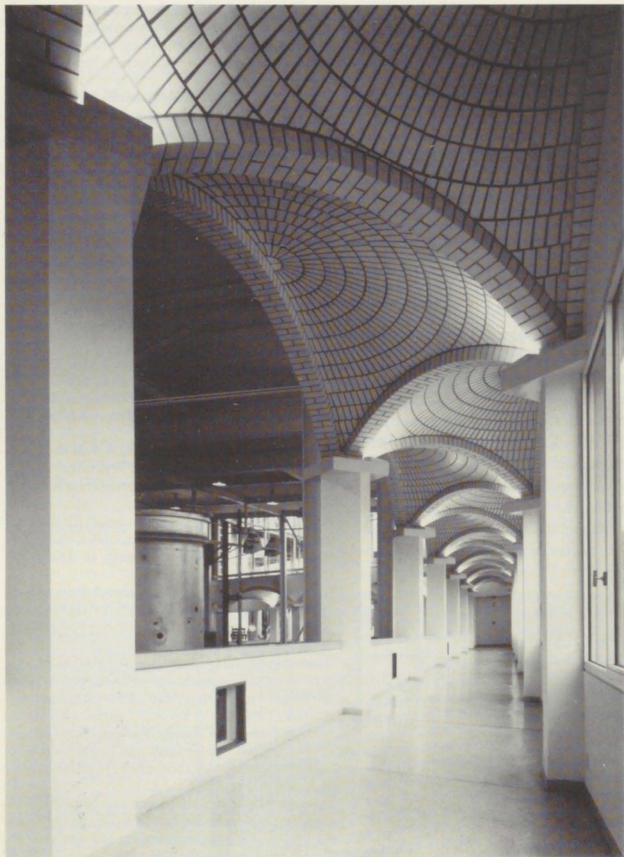
Kreuzrippengewölbe im Wegehaus
