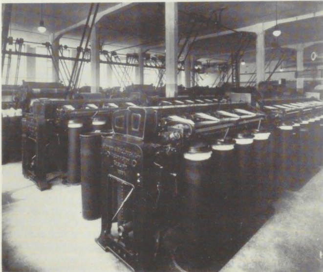
Streckmaschinen von Howard & Bullough Ltd, Accrington, Baujahr 1889. Aufgenommen in der Spinnerei Atzenbach AG um 1900
