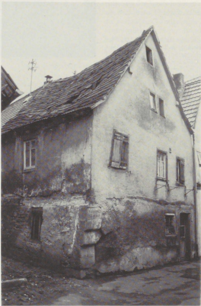
Tauberbischofsheim, Untere Gasse 2, Handwerker- oder Kleinbauernhaus mit Stallungen und Ökonomieräumen im EG (bez. „Georg Dilman/1591“), abgebrochen, Aufn. 1988.
