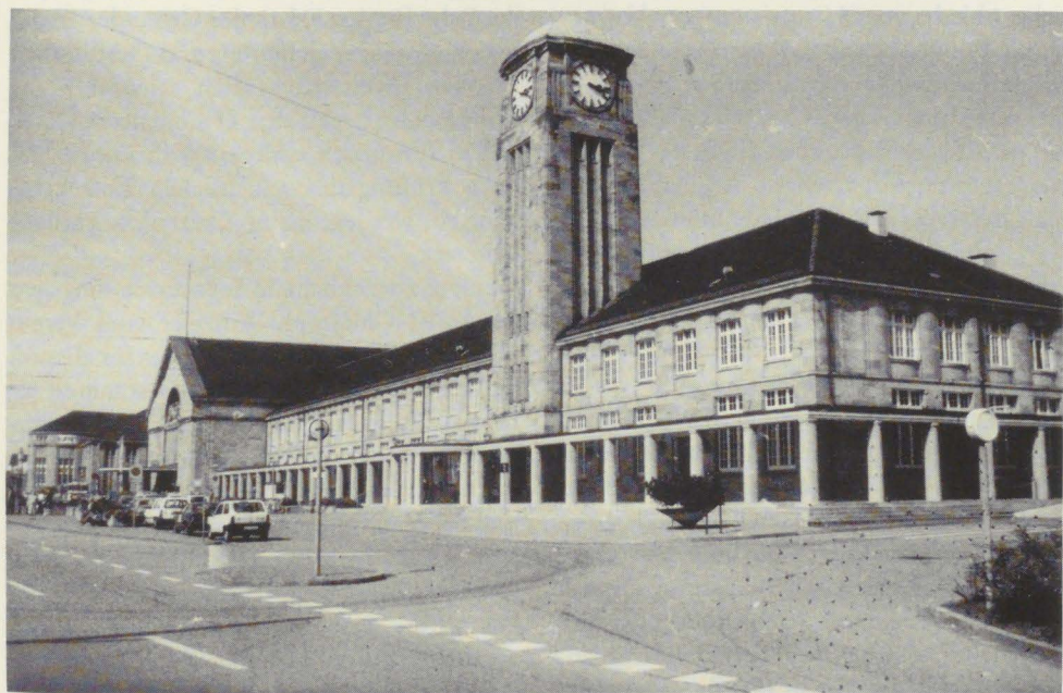
Badischer Bahnhof: Denkmalpfleger wollen Einkaufszentrum verhindern (Copyright: Pressebüro Hans-Walter Neunzig)
