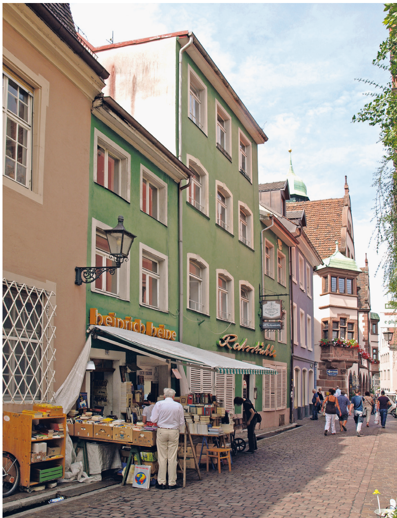
Abb. 1 Freiburg, Universitätsstr. 6 bis 2. Die Straßenfassaden der Häuser vor dem Abbruch 2016 (Foto: Frank Löbbcke).
