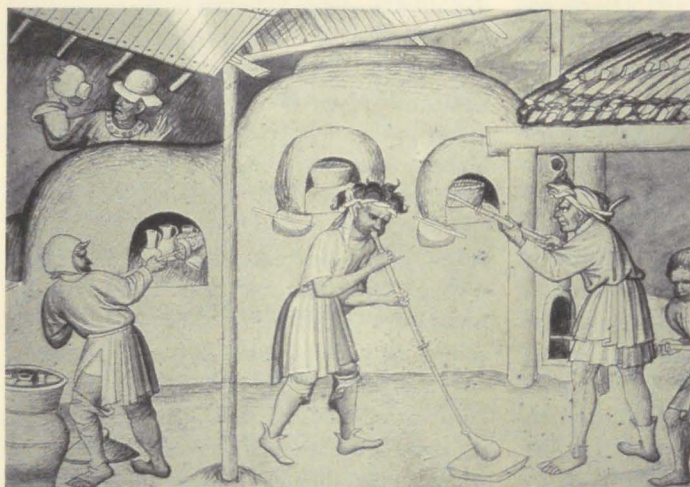
Die Arbeiten am Hüttenofen (von rechts nach links): Schüren (unteres Loch), Glasmasse erhitzen; Blasen, Abkühlen, Ware prüfen (links oben)
