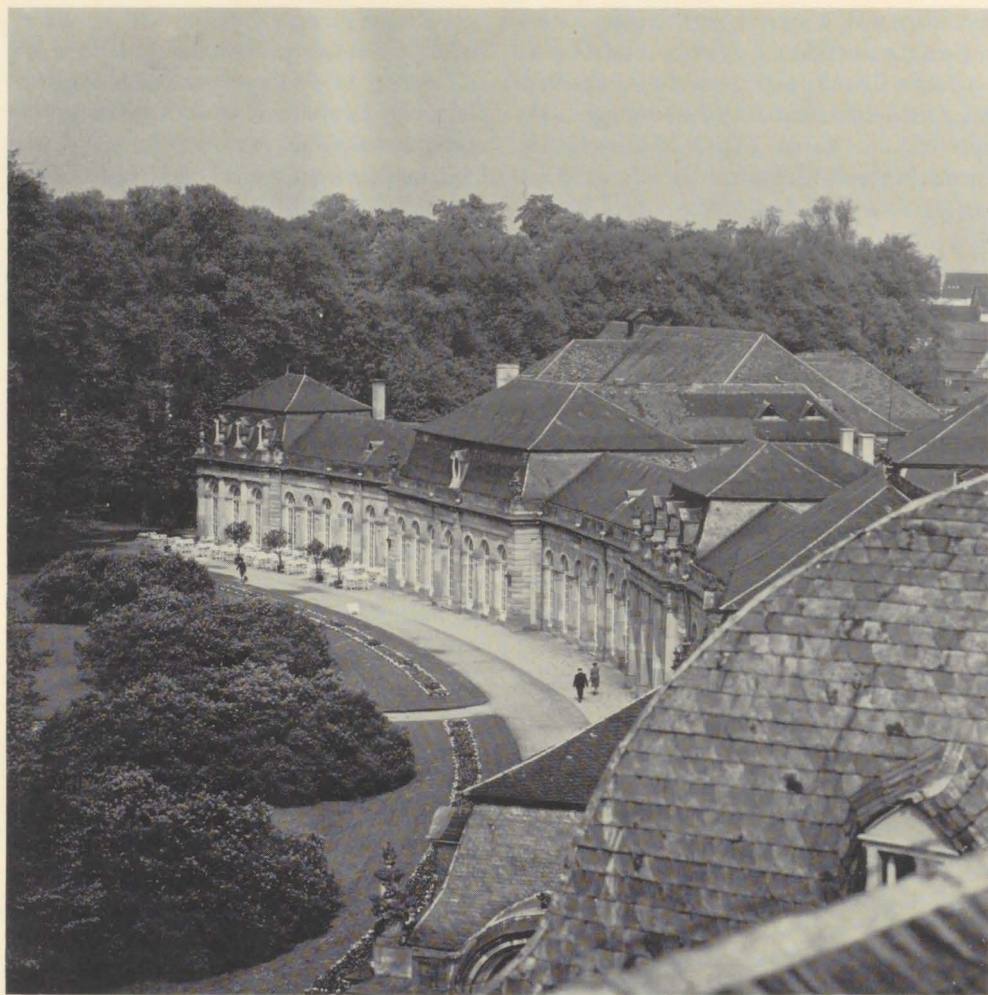
Blick vom Schloß-Mittelbau auf den nördlichen Zirkelbau mit Theateranbau (Foto: Joachim Schmidmann, Augustaanlage 26, 6800 Mannheim 1)
